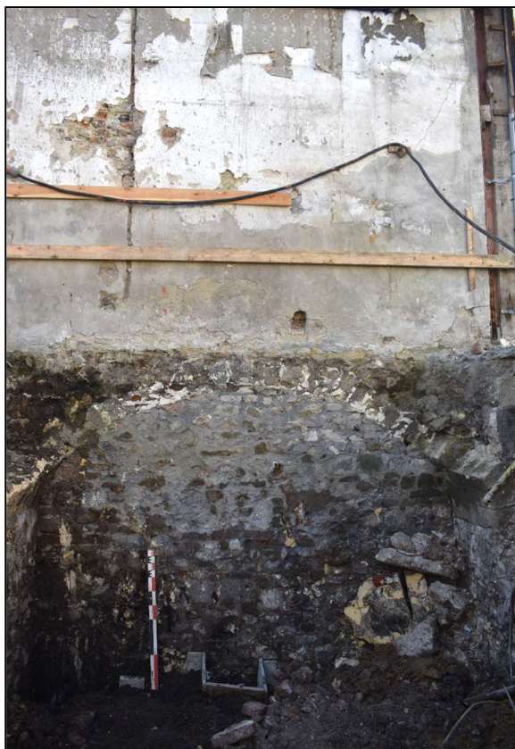
Fig. 52: Westwand van kelder op scheiding nr. 45-47 (Aron bv, 8/03/2022, 2021I201).
