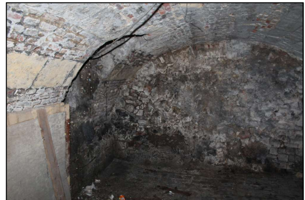
Fig. 49: Kelder nr. 49 - oostelijke wand (DFM Architecten).
