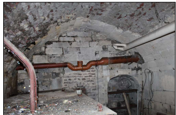
Fig. 51: Kelder nr. 49 - oostelijke wand (DFM Architecten).
