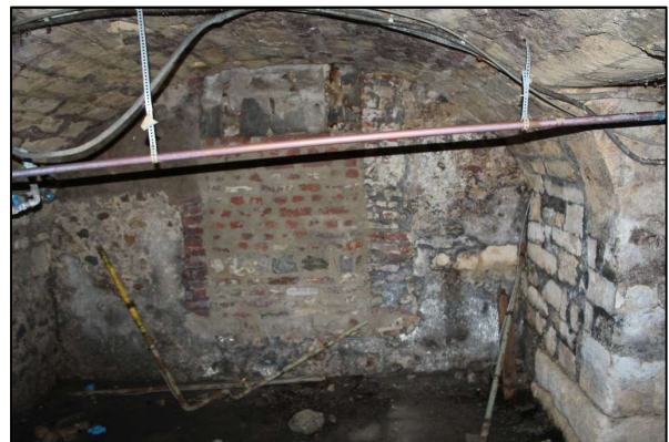
Fig. 47: Kelder nr. 47 - oostelijke wand (DFM Architecten).
