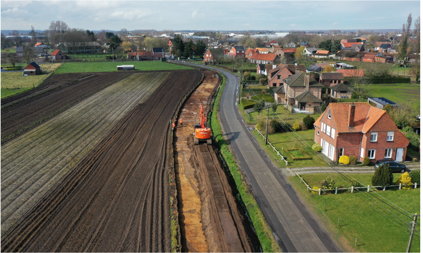
Figuur 24: Zicht op de aanleg van het vlak vanuit het oosten
