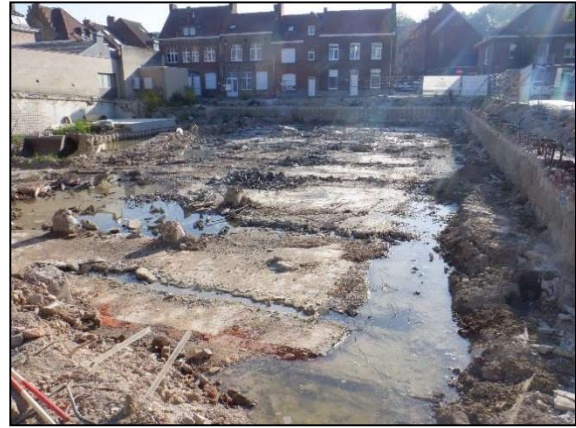
Figuur 2: Situatie na/tijdens de sloop.
