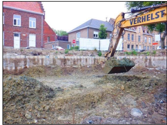
Figuur 4: Situatie na/tijdens de sloop
