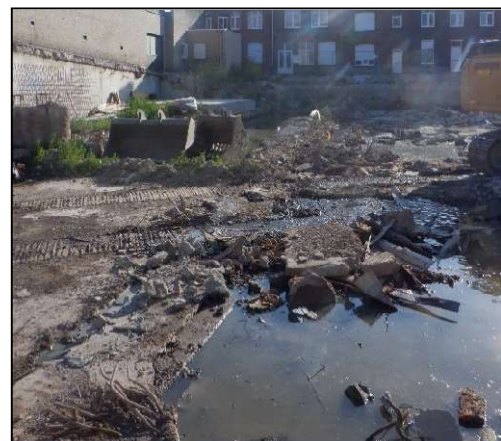
Figuur 6: Situatie na/tijdens de sloop
