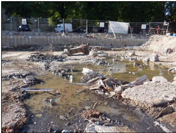
Figuur 3: Situatie na/tijdens de sloop
