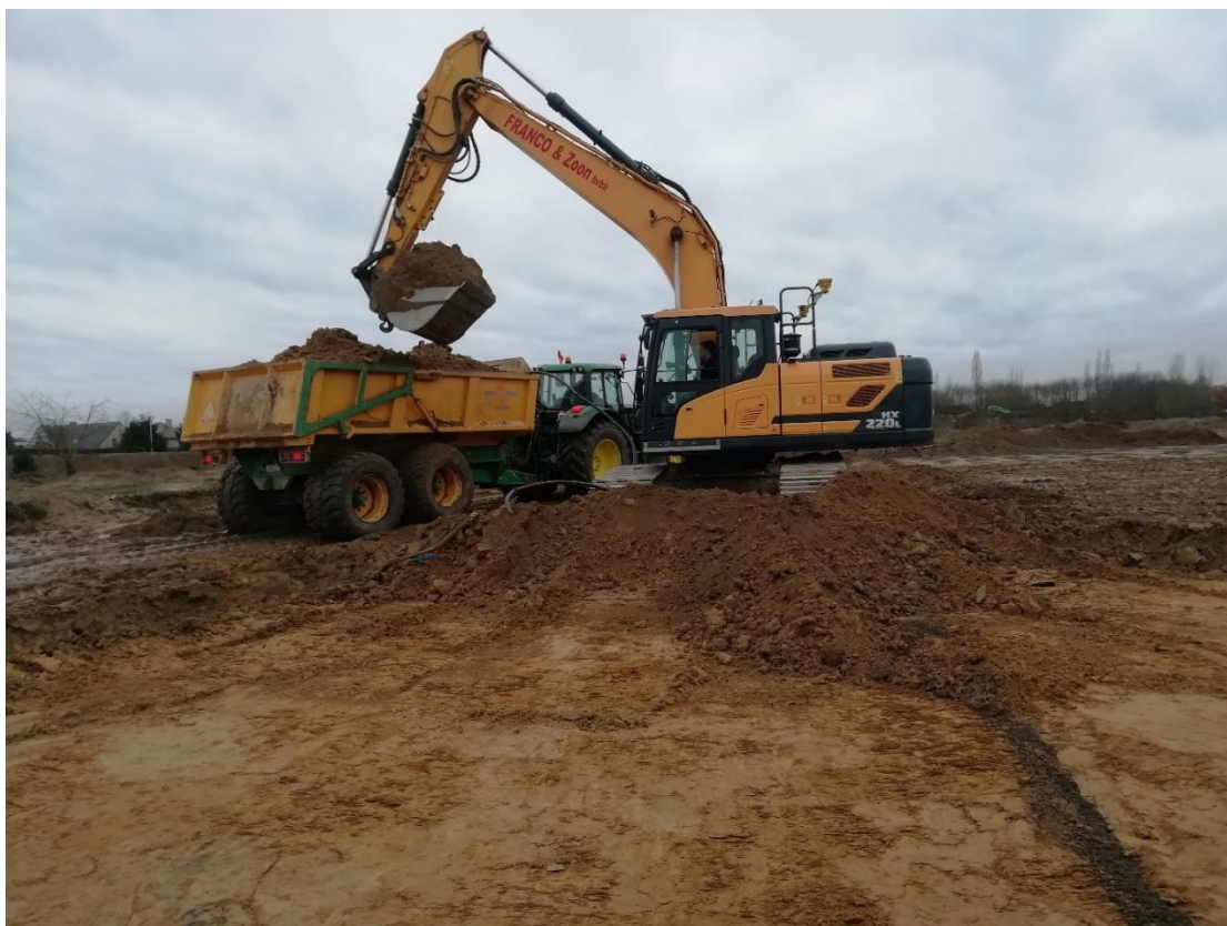
Figuur 9: Afgraven met kraan en dumper (15/02/2020).
