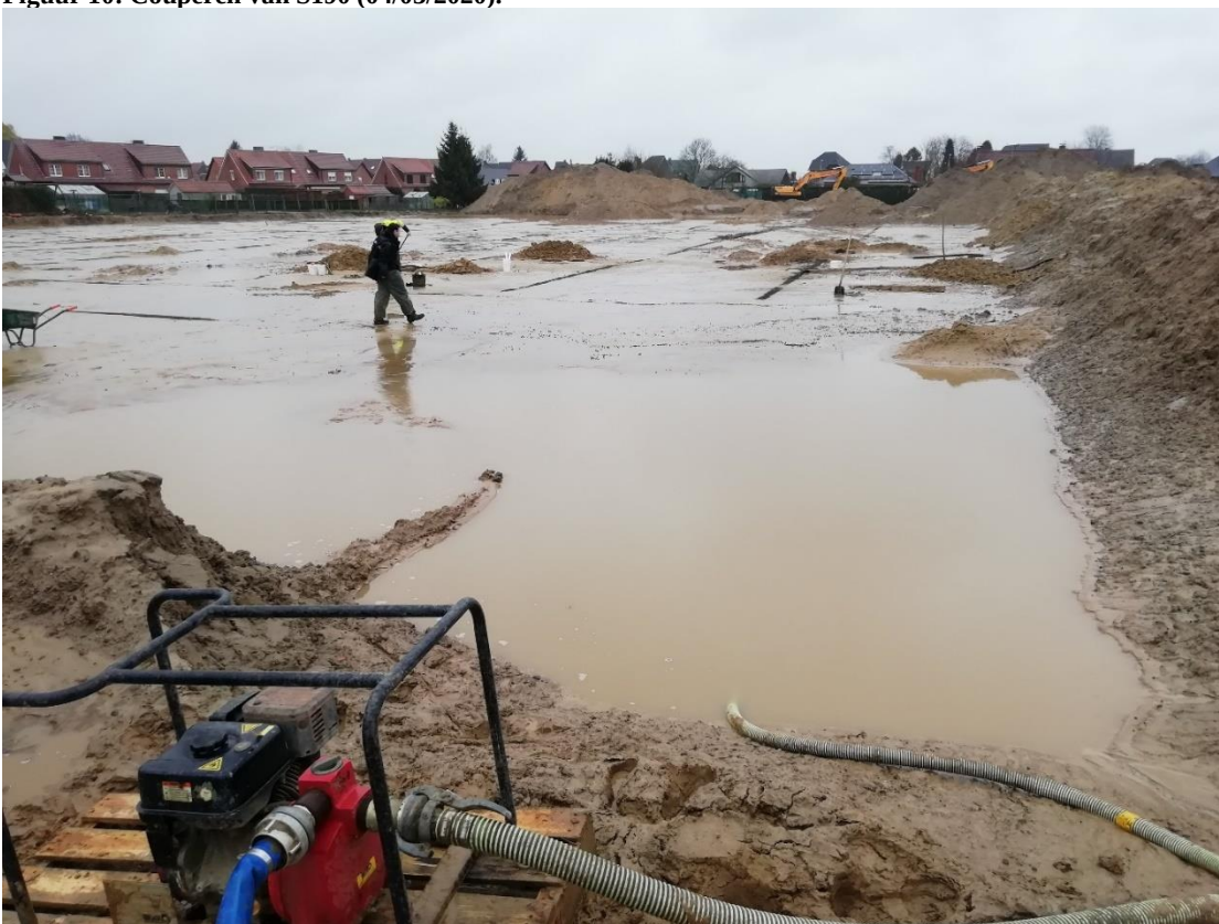
Figuur 11: Water wegpompen uit werkput 4 (02/03/2020).
