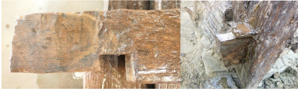
Afb. 6.20. Detail van dwarsbalk vnr. 201 links en rechts de situatie met wig zoals aangetroffen in het veld.
