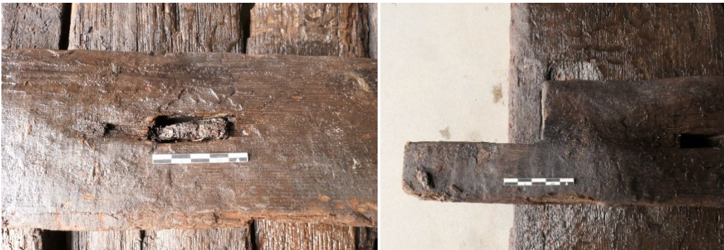
Afb. 6.24. Details van dwarsbalk vnr. 200 met restanten van plankjes en een versmalling aan het uiteinde.
