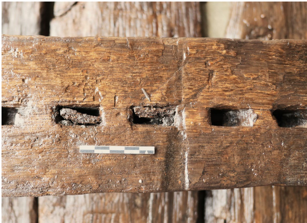
Afb. 6.16. Detail van dwarsbalk vnr. 155 met restanten van latjes.
