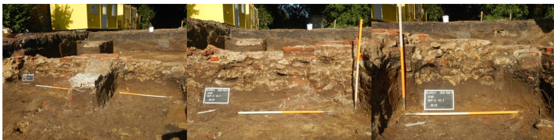
Figuur 77: Detailfoto's muur M16; in noordwestelijke richting (© ARCHEBO bv).
