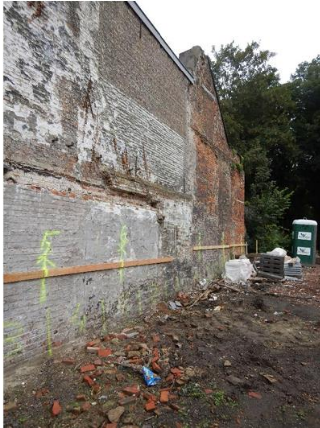
Figuur 5: Muur waarlangs beschoeiing dient geplaatst te worden (© ARCHEBO bv).
