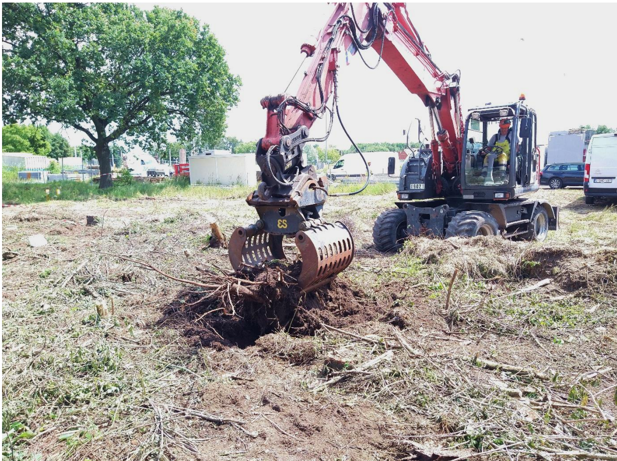
Figuur 5: Machinaal verwijderen van de boomwortels.
