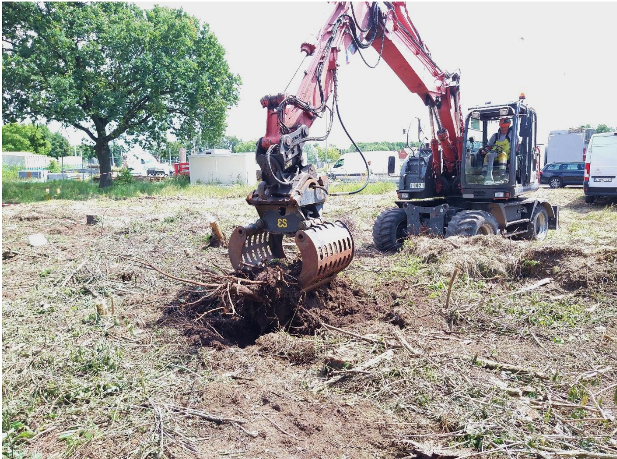
Figuur 5: Machinaal verwijderen van de boomwortels.
