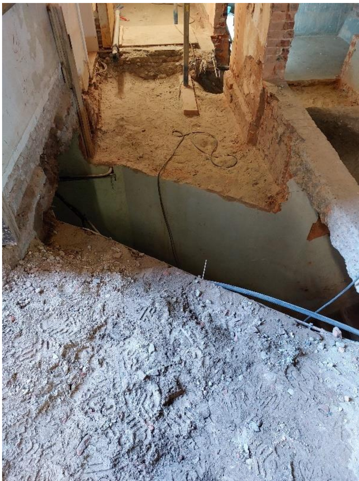
Figuur 9: Fotografische opname van de gang naar de ondergrondse bunker die open kwam te liggen tijdens de afbraakwerken.
