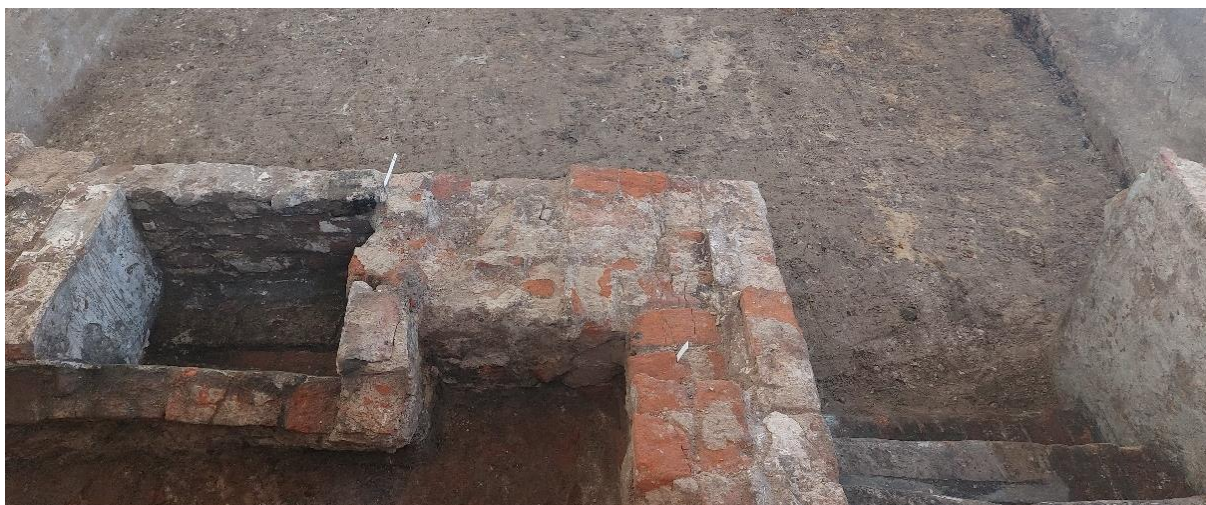
Figuur 35: Fotografische opname van de stortkoker S4 (links). Rechts de traptoegang tot de kelder.
