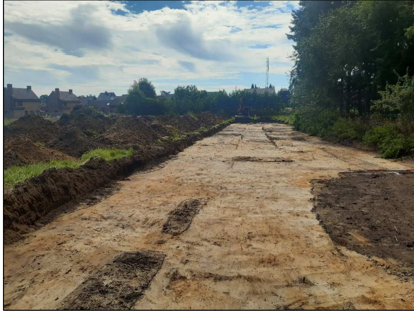
Figuur 1: Zicht op werkput 1 in zuidoostelijke richting
