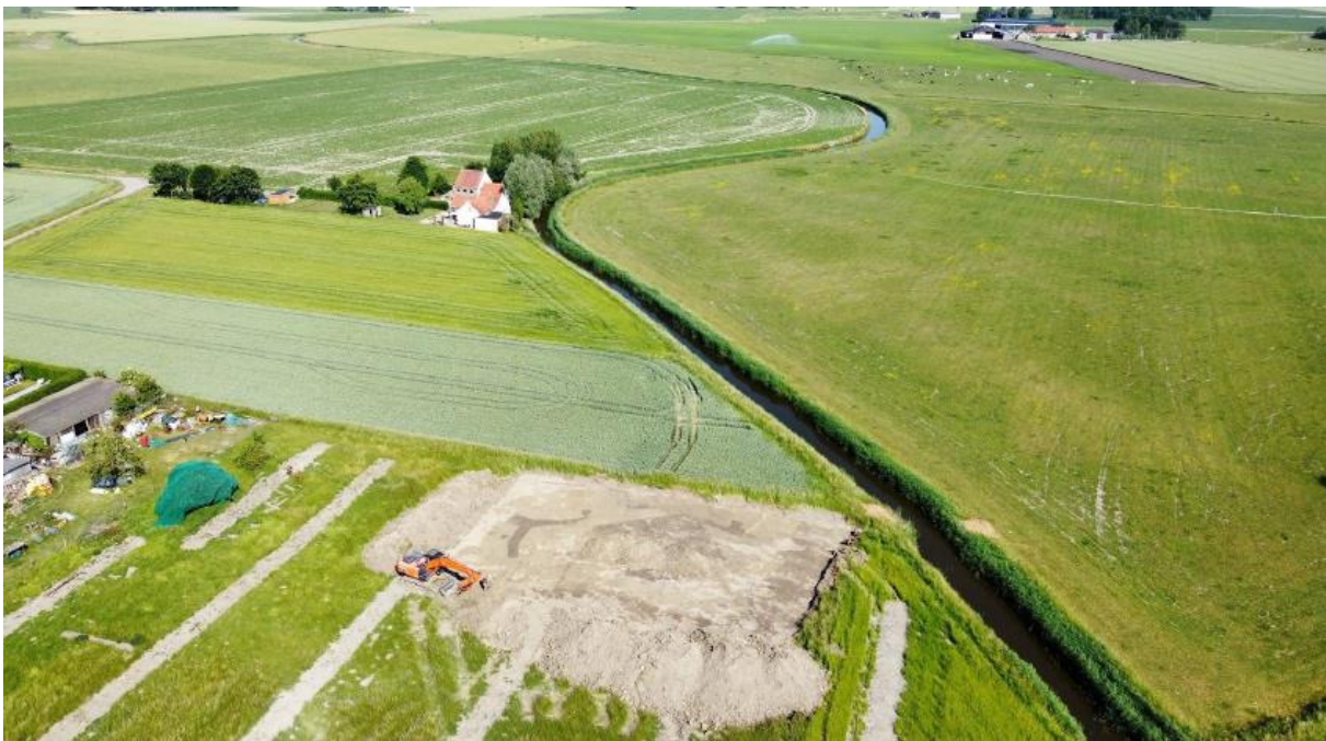
Figuur 6: Overzicht van de aanleg van het projectgebied (© Raph De Brant).
