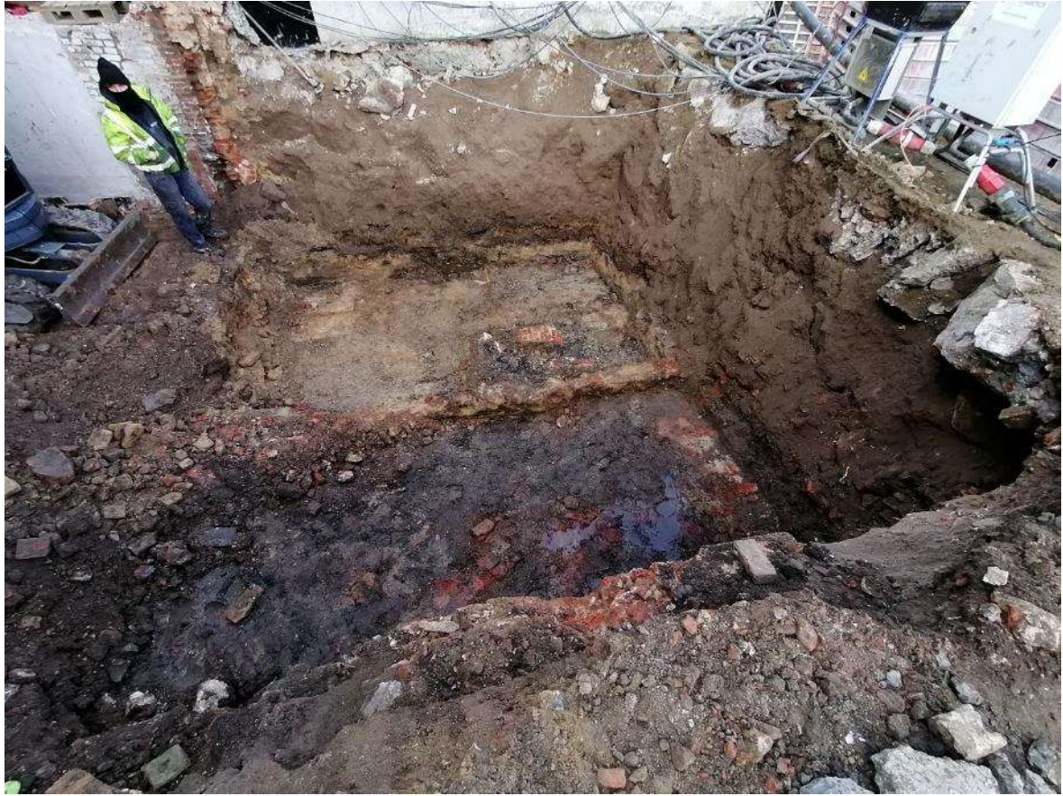
Figuur 59: Toestand van het terrein, fase 2B, met links een deel van het talud
