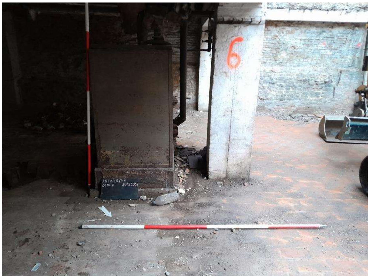
Figuur 56: Toestand van het terrein, fase 2A, met enkele te behouden zuilen en de vloerplaat
