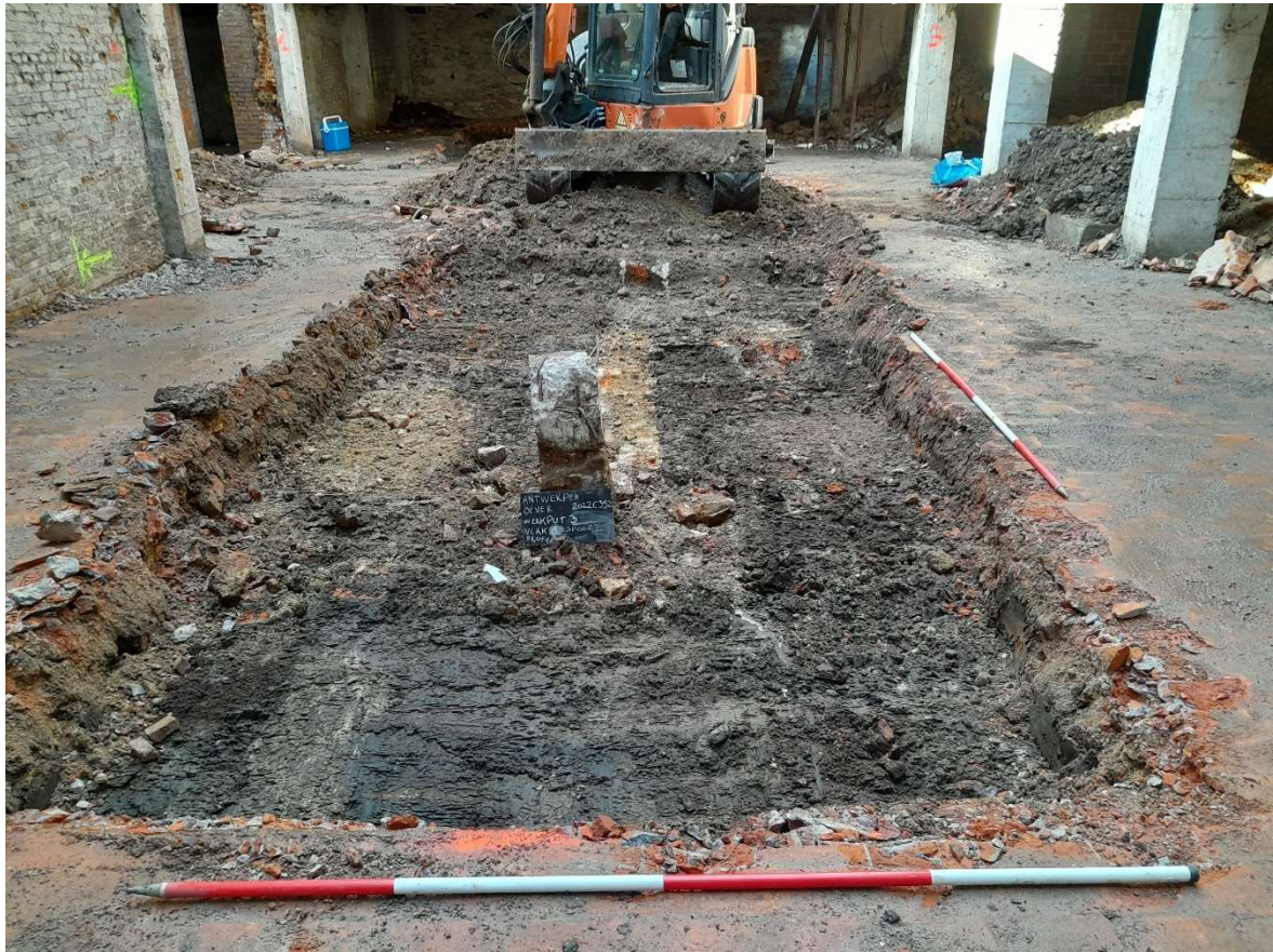
Figuur 172: Verstoring in werkput 3
