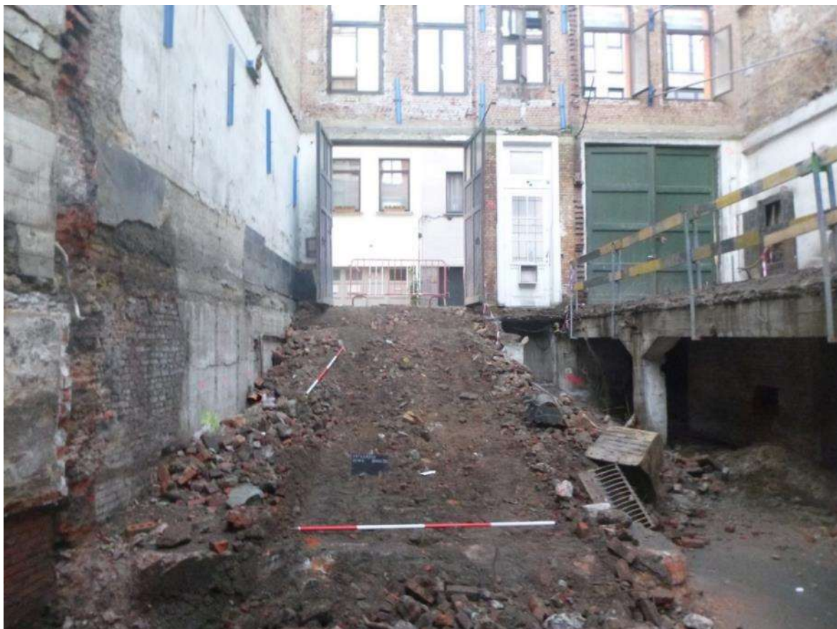
Figuur 58: Toestand van het terrein, fase 2A, talud
