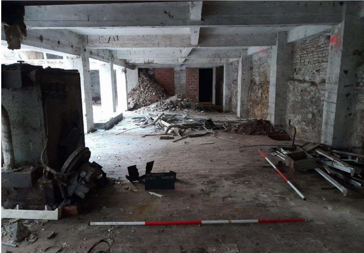
Figuur 55: Toestand van het terrein, fase 2A, met enkele te behouden zuilen en de vloerplaat
