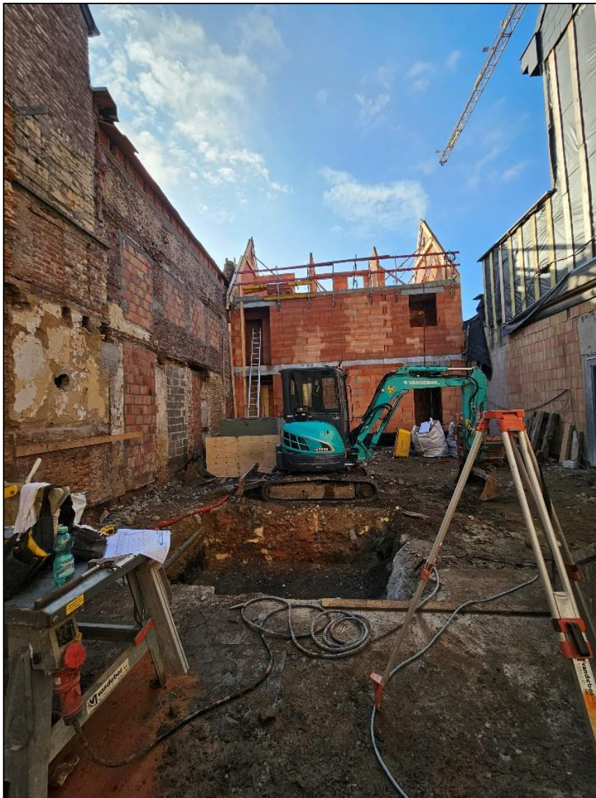
Afb. 8: Zicht op de werfzone bij het uitgraven van de liftput (WP4).
