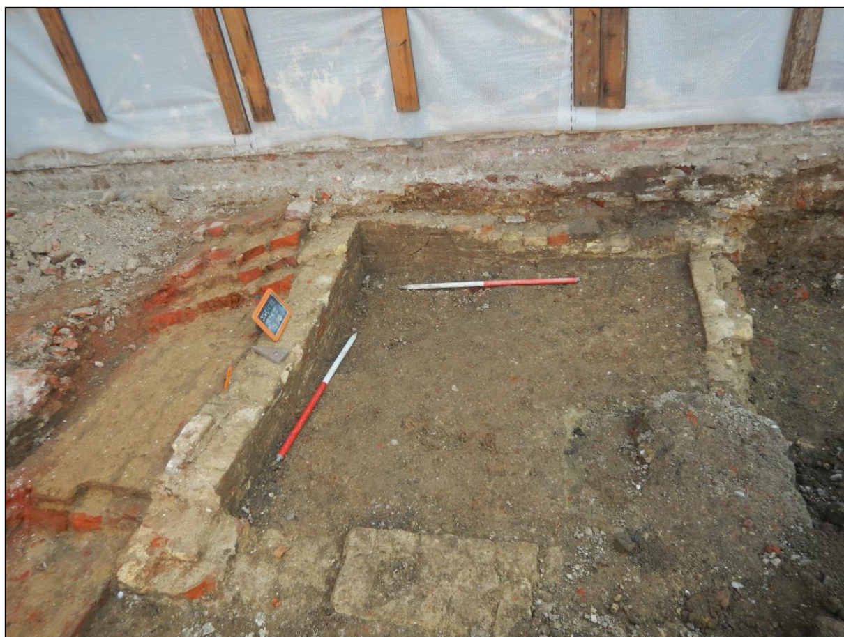
Figuur 126: Bakstenen kelderstructuur S80 (26x13x6cm), tegen bakstenen muur S79 gezet (27x12x5,5cm) gezet.
