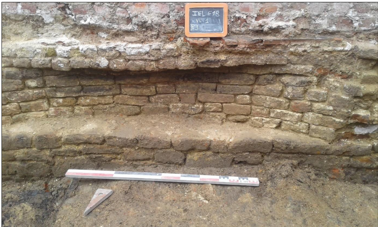
Figuur 113: Haardmond S27, bovenop de onderliggende ijzerzandstenen muur S26 opgebouwd met hoofdzakelijk gele bakstenen.
