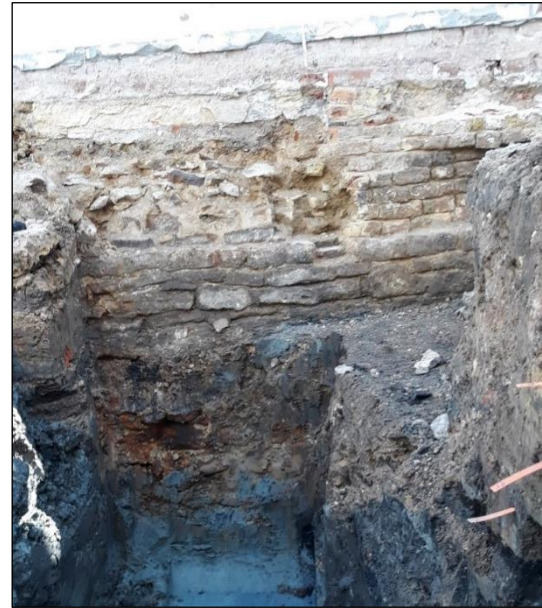
Figuur 62: Zicht op een lokale verdieping langs de zuidelijke muur (S26) van het eerste ijzerzandstenen gebouw. De brokkelige fundering ging, onder de rechthoekig gekapte paramentblokken, nog 1,2m diep. In de meter erboven zijn de rechte paramentstenen weg, mogelijk voor hergebruik. Rechts daarvan zijn de bakstenen van de jongere muurhaard S27 te zien.
