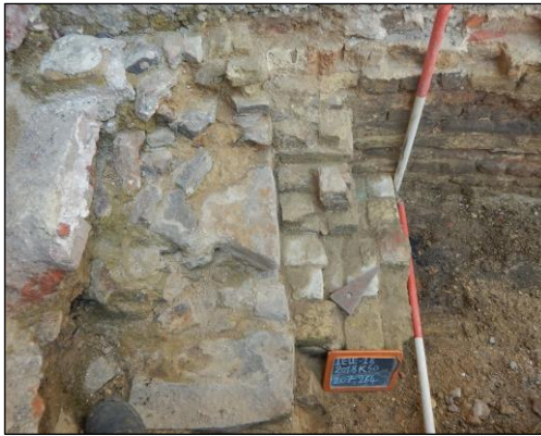
Figuur 65: Stuk van de vermoedelijke noordwestelijke hoeksteunbeer/muur S207. In een postmiddeleeuwse bouwphase werd er aan de binnenkant een bakstenen muur (baksteenformaat: 20x10x5,5cm) tegen gebouwd.
