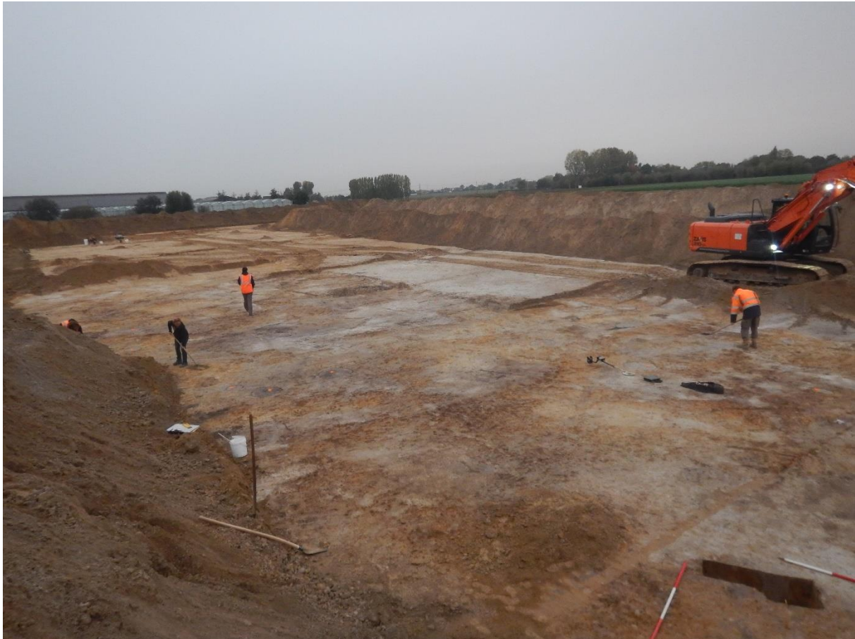
Figuur 3: Aanleg vlak met 18 tons kraan.
