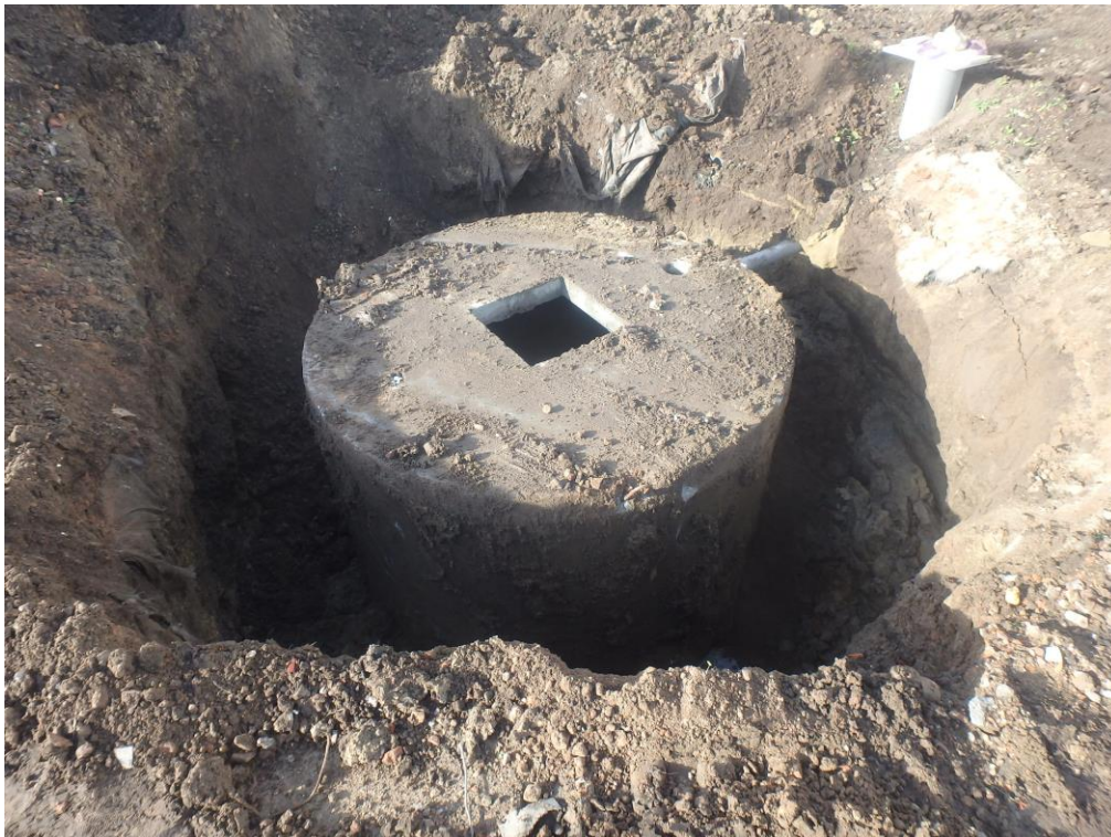
Figuur 96: Zicht op de blootgelegde regenwaterput en vrijgekomen wanden (© ARCHEBO, 2021).
