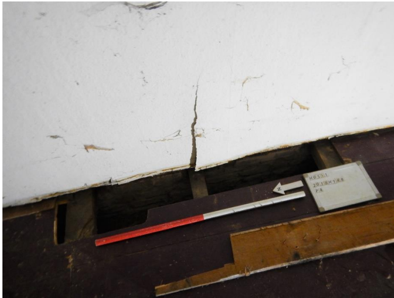
Figuur 35 Foto van werkput 4 in zone 2 waar plaats gemaakt werd voor een radiator met zicht uit het noordwesten.
