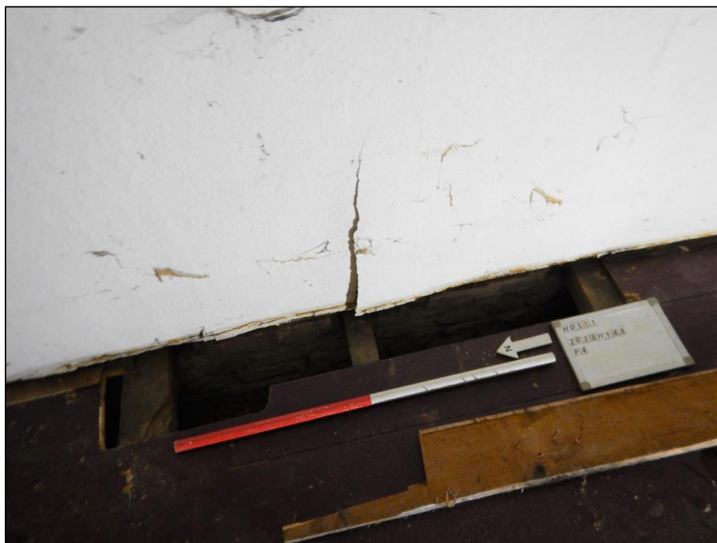
Figuur 10 Foto van werkput 4 (zone 2) met zicht vanuit het westen.
