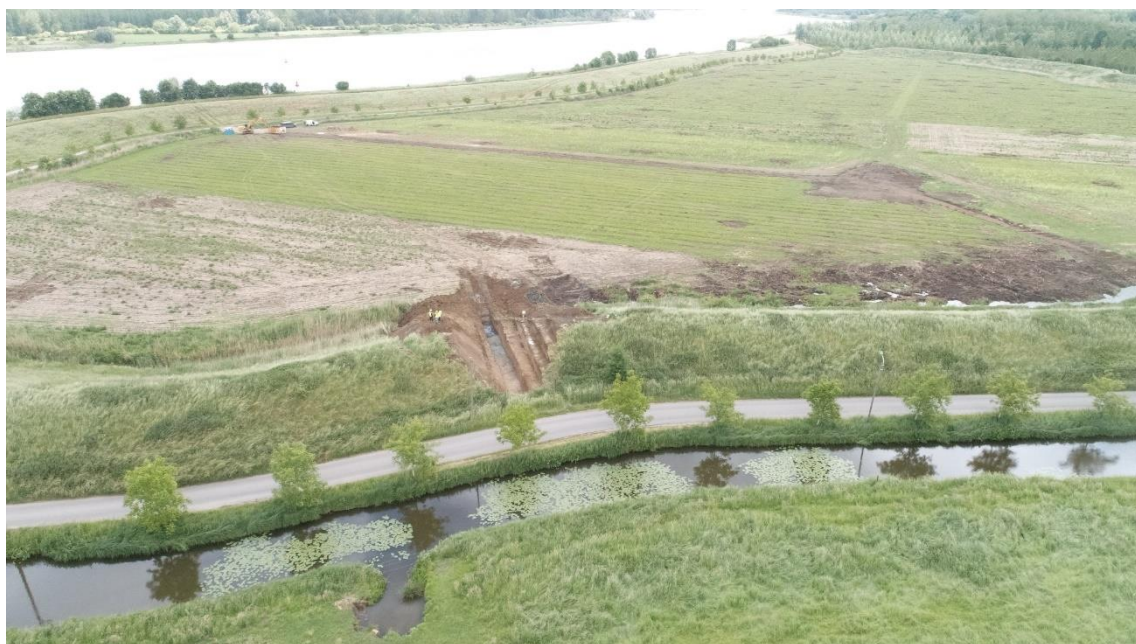
Figuur 12: Overzichtsfoto van aanlegde getrapte dijkdoorsnede met daarachter het Groot Schoor.
