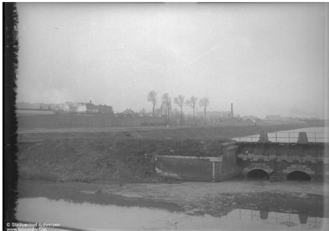
Figuur 18: Foto vanaf de trambedding richting het westen met zicht op de Schijnpoortbrug uit 1930-1935 (Bron: FelixArchief, inventarisnummer GP#642).
