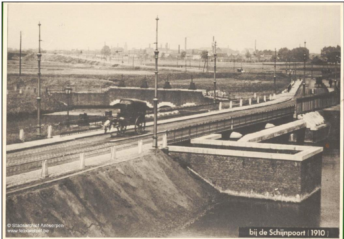
Figuur 16: Foto vanuit de binnenstad richting het oosten met zicht op de Schijnpoort uit 1910 (Bron: FelixArchief, inventarisnummer FOTO-OF#83).
