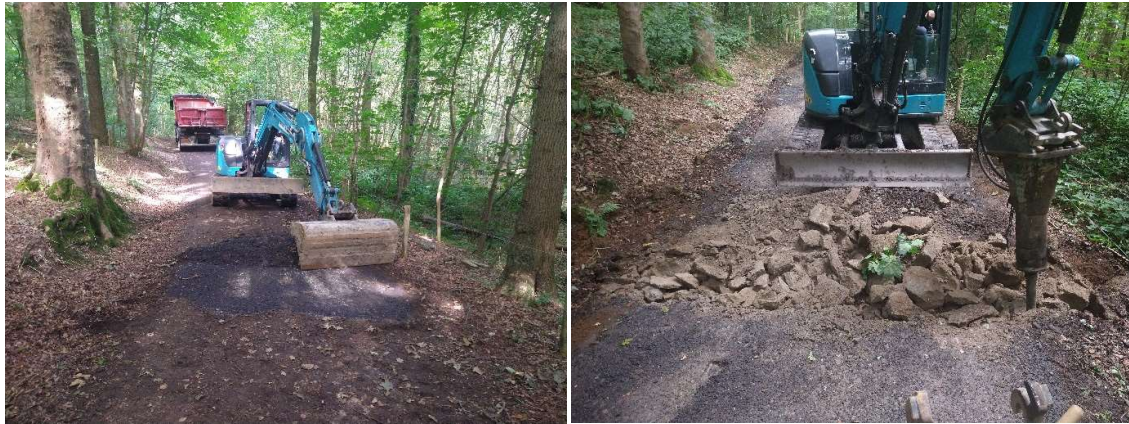
Figuur 5. Links: Het afgraven van de ophoging met een 5,5 ton kraan. Op de achtergrond de vrachtwagen met laadbak. Rechts: Het verwijderen van de PVC-buis met een hydraulische breekhamer.
