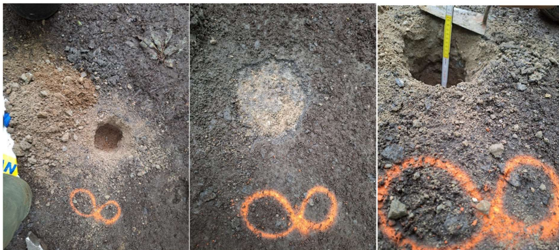
Figuur 7. Foto van boring 8 uitgevoerd door de provincie West-Vlaanderen. Links: de C-horizont onderaan de boring. Centraal: de overgang van betonpuin naar kalksteenslag. Rechts: een foto van de doorsnede van de boring (bron: provincie West-Vlaanderen).
