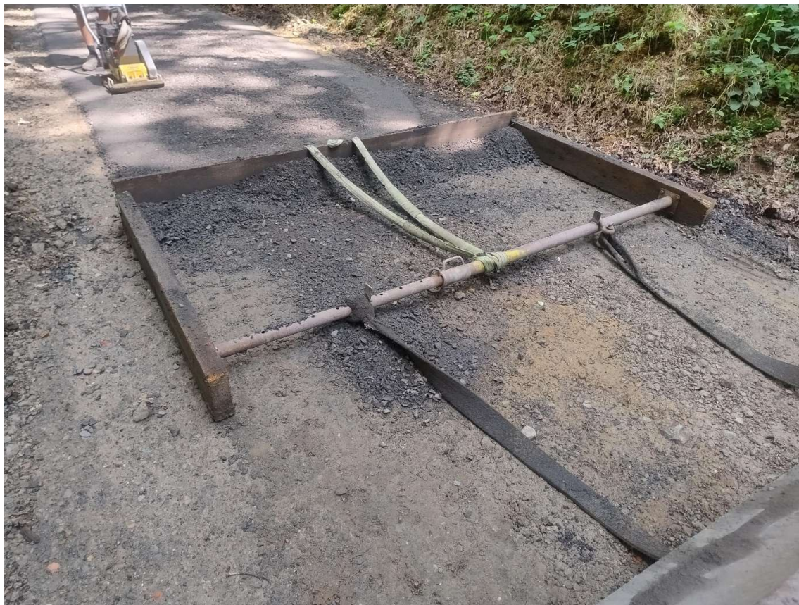
Figuur 6. Door middel van een trekbak van 2,5 m breed en een opening van 5 cm hoog kon de Lokerdreef met hoge precisie worden aangelegd.
