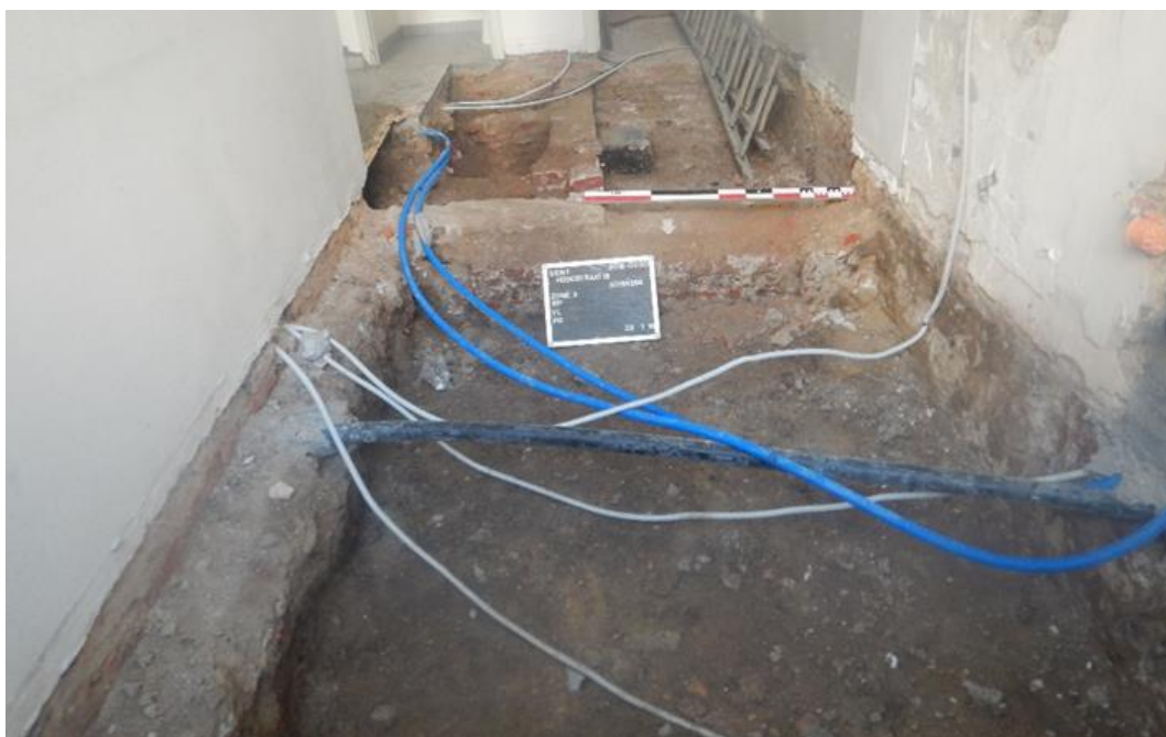
Figuur 4: fase 1; opvolging van het graven van de liftput in zone 3.
