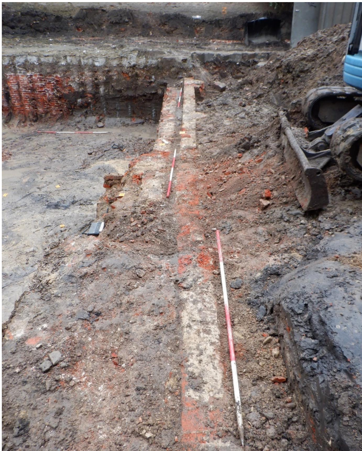
Figuur 34: detailfoto van de parallel lopende funderingen 1064 (links) en 1065 (rechts).
