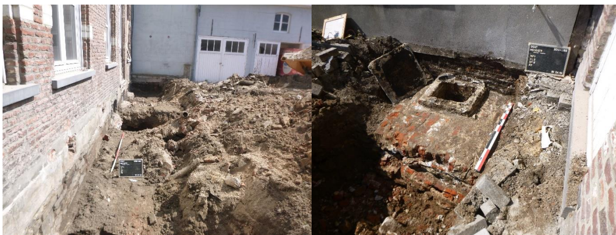
Figuur 6: fase 2; opvolging van enkele sonderingsputten tegen de buitengevel van de gebouwen in zone 1.
