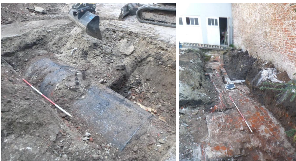
Figuur 5: fase 2; verwijderen van de mazouttank (links) en documenteren van de fundering van de oorspronkelijke kloosterkapel (rechts) tegen de zuidelijke perceelsmuur.
