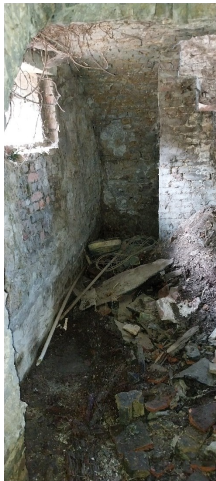
Figuur 78: Werkfoto van de kelder met links het raam dat zich ter hoogte van werkput 1 bevindt (foto Harry Van Royen)
