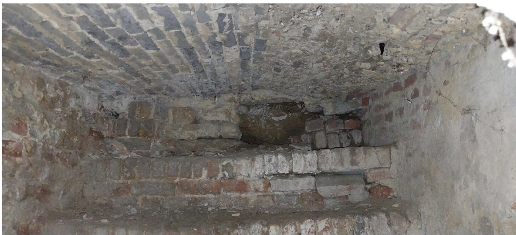
Figuur 80: Bovenzijde van de oorspronkelijke toegang tot de kelder (keldertrap) met bovenaan het gewelf waarmee de kelderopening is dichtgemetst (foto Harry Van Royen)
