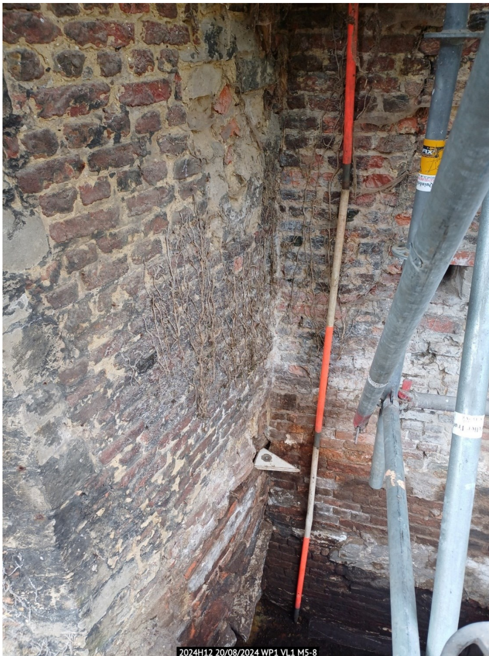
2024H12 20/08/2024 WP1 VL1 M5-8 Figuur 105: De bouwnaad ter hoogte van waar het hoofdvolume (rechts) aansluit op de toren (links)
