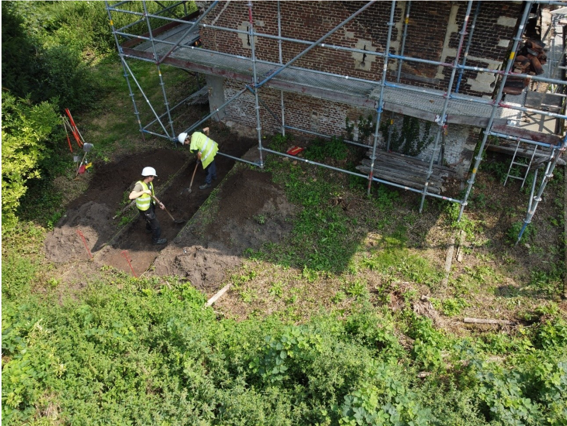
Figuur 27: Uitgraven van werkput 2
