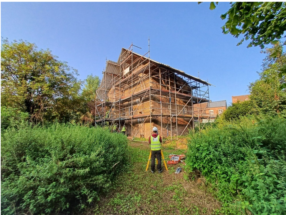
Figuur 28: Opmeten van basispunten voor het georeferen van het gebouw en het bepalen van de TAW-hoogtes
