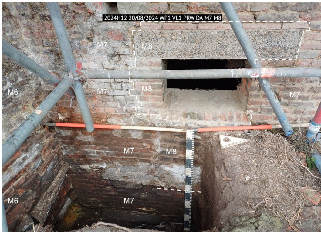
Figuur 77: Werkput 1, profiel PRW (DA) met keldermuur M7, waarvan het keldergat gedeeltelijk is dichtgemetst (M8)
