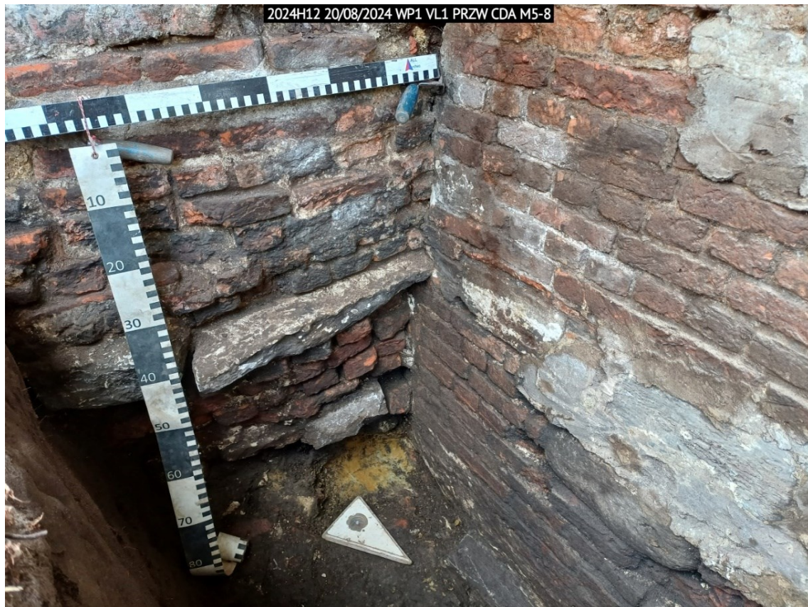
Figuur 76: Detail van de relatie tussen de fundering van het torentje (M6, links) en de kelder (M7, rechts)
