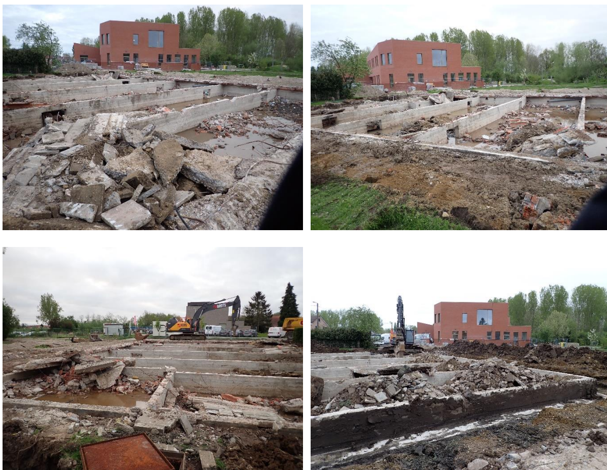
Figuur 16: Overzichtsfoto's van de kruipkelder voorafgaand en tijdens de werfbegeleiding ( © J. Verrijckt Bvba)
