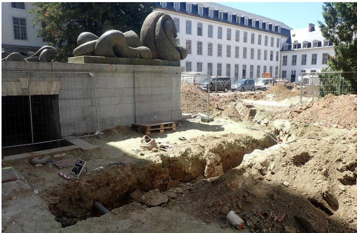
Figuur 18. Begeleiding van het uitgraven van de volgsleuven (hier WP5) voor nutsleidingen.
