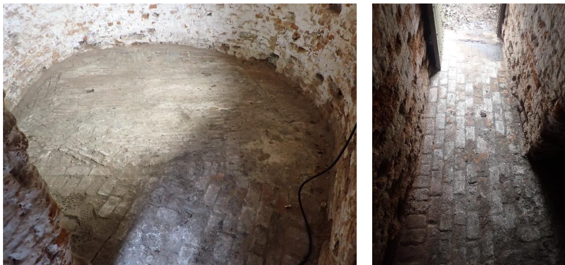
Figuur 19. De bestaande vloer binnenin de toren, na het vrijleggen en schoonmaken ervan.
