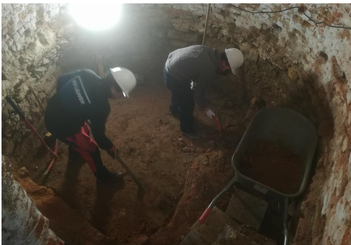
Figuur 20. Het graafwerk kon alleen worden uitgevoerd met behulp van kunstmatig licht.
