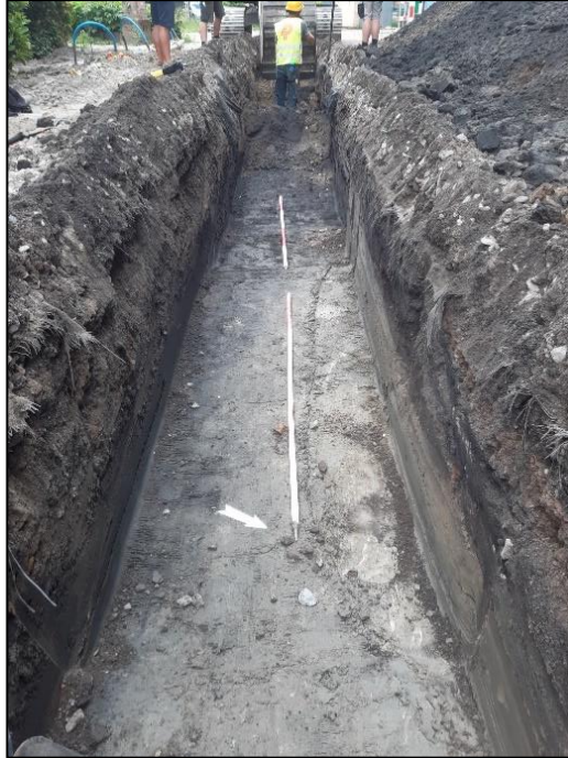
Figuur 7: Zicht op de versterking in het zuidelijke deel van werkput 2
