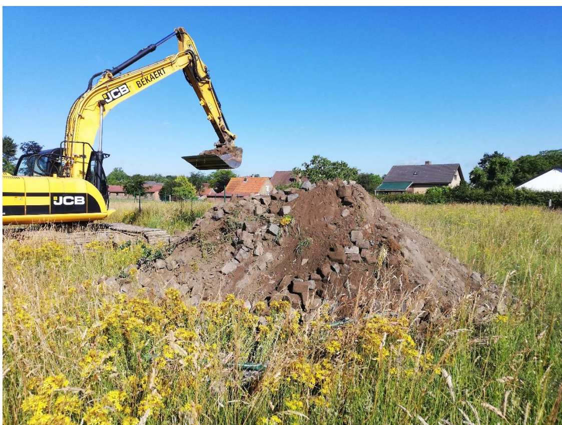
Figuur 11: Verwijdering van de kasseiwegen.
