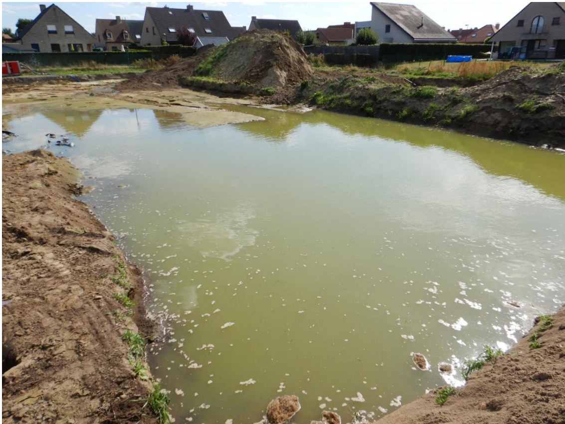
Figuur 12: Zicht op Wp2 die gebruikt werd voor het stockeren van het opgepompte grondwater.
