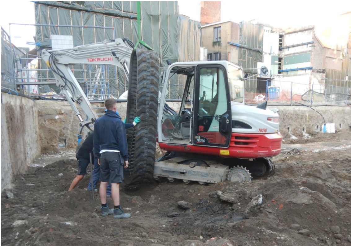
Figuur 39: Herstellen losgekomen rupsband bij de kraan
