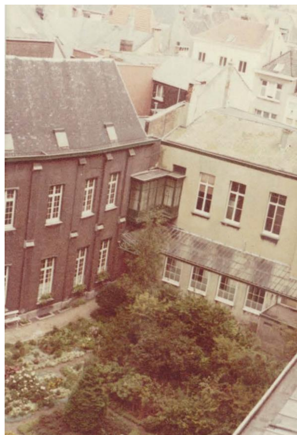
Figuur 247: Historische foto met zicht op de binnentuin van het Klooster van de Paters Minderbroeders met links de noordoostelijk vleugel (archief)
