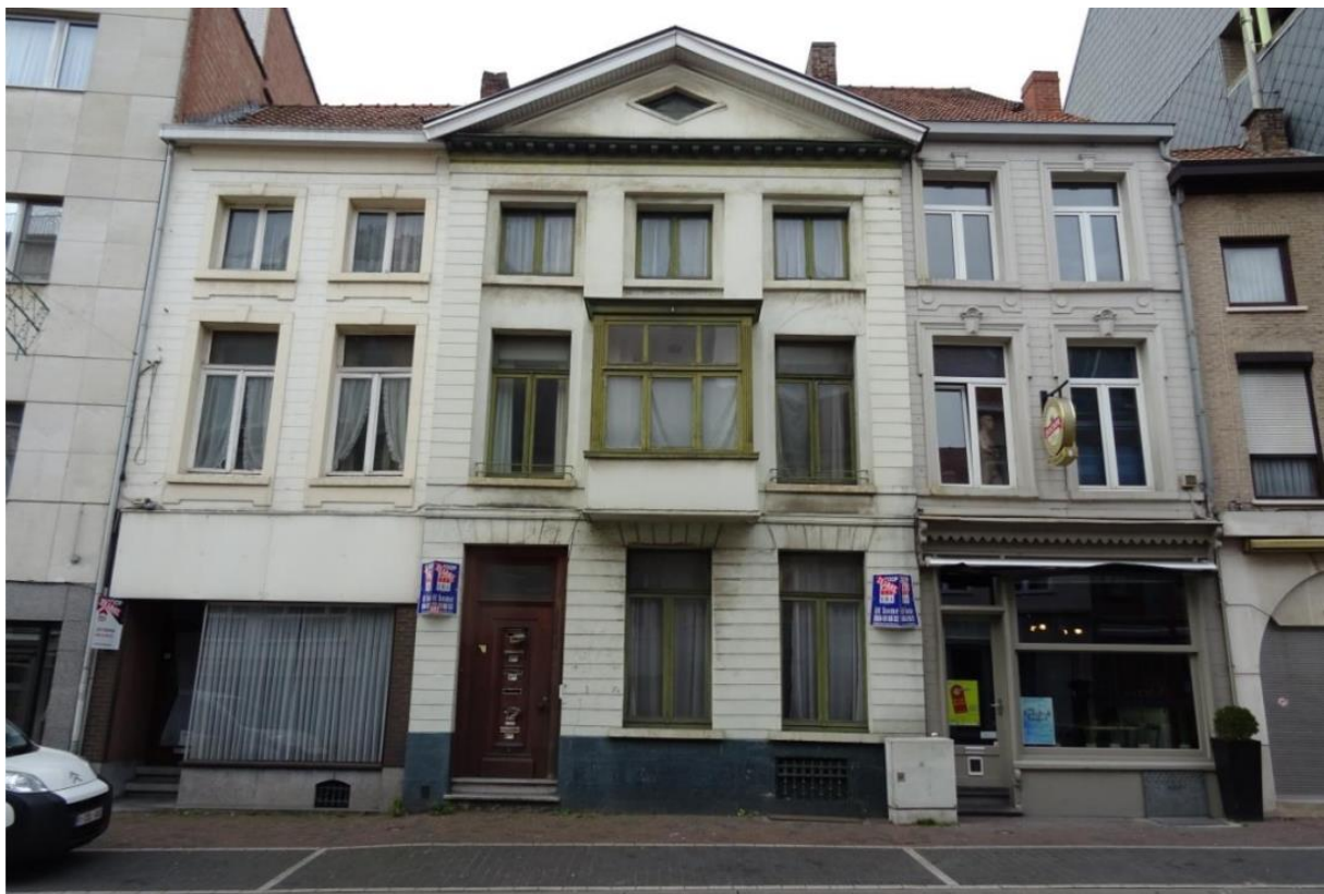
Figuur 5: Vooraanzicht van de panden vanuit de Bruggestraat (bron: architect).
