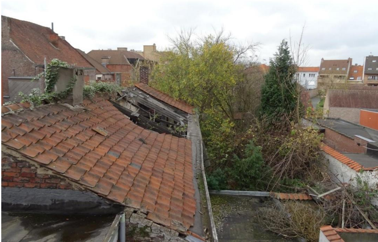
Figuur 6: Zicht op de achterbouw en de tuinzone ter hoogte van huisnummer 6 (bron:architect)
