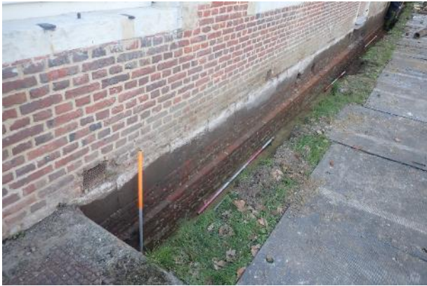
a) WP1, zicht vanuit het zuidoosten.
