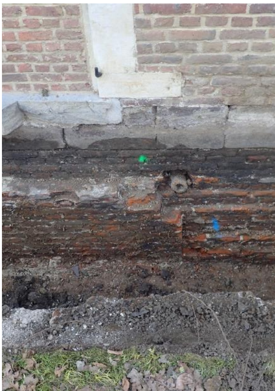
Figuur 32. Bouwnaad in de funderingen tussen S18 (links) en S19 (rechts); foto genomen nadat de sleuven werden uitgediept. De naad valt ongeveer samen met de noordelijke deurstijl van de dichtgemaakte opening in de annex (oorspronkelijke deur werd venster; de deurdrempel bevindt zich echter nog in situ in het metselwerk).
