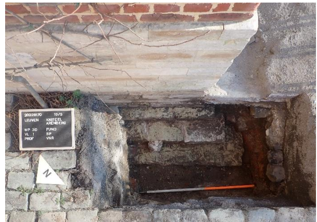
d) Detail uit WP3d, waarop de 3 treden van de fundering (stylobaat/stereobaas) te zien zijn.
