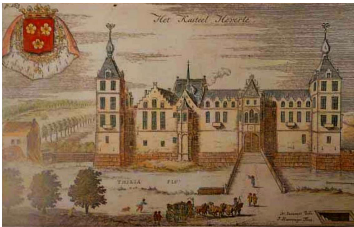
Figuur 40. Op deze prent uit 'Délites du Brabant et de ses Campagnes' (1757) is de afgeschuinde natuurstenen plint rondom het kasteel duidelijk weergegeven. Tegenwoordig is deze bijna volledig begraven onder ophogingslagen (Beyen e.a. 2011, II.29 Fig. 105).
