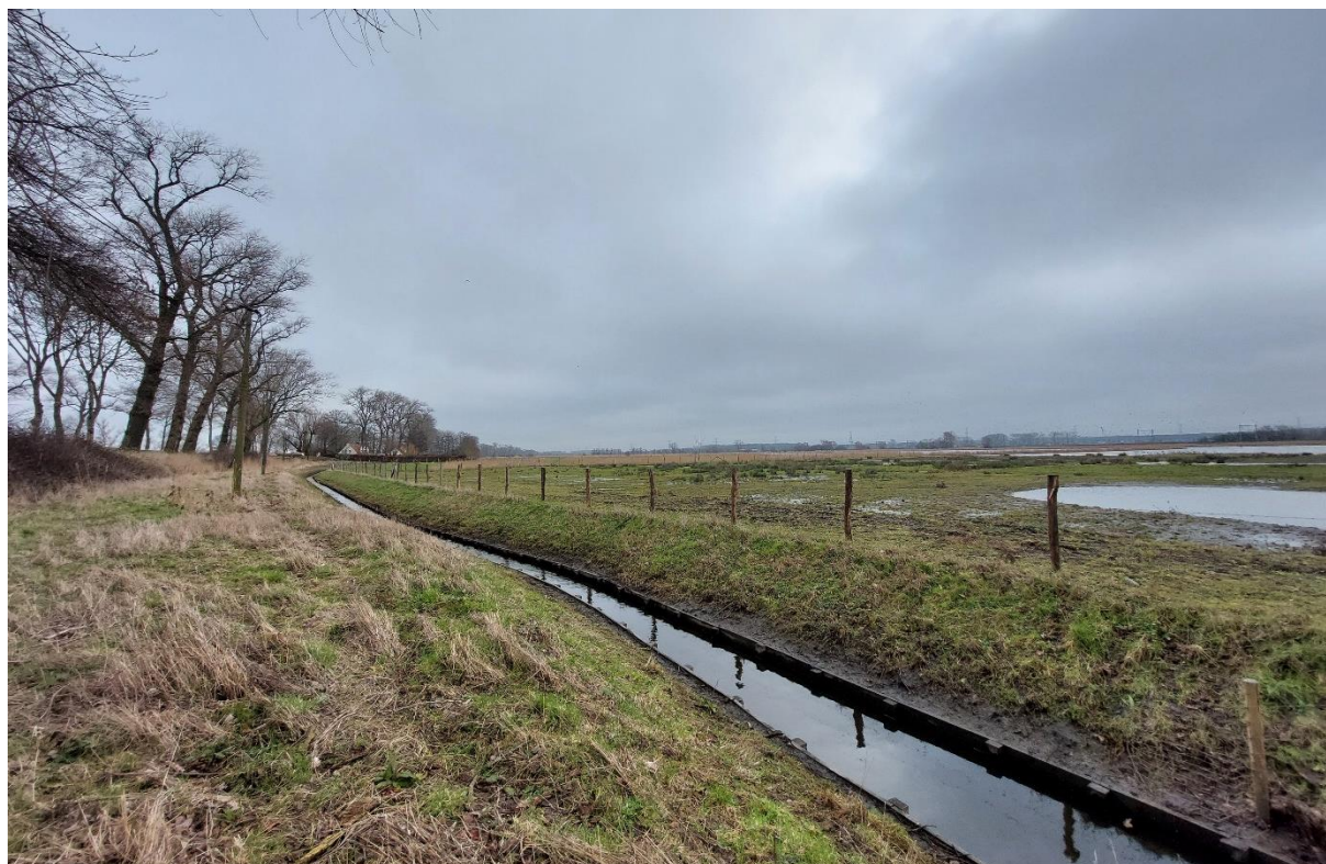
Figuur 16: Ondertussen werden de voorziene werken uitgevoerd. Op 2 februari 2024 was dit het zicht op de opgegraven zone.
