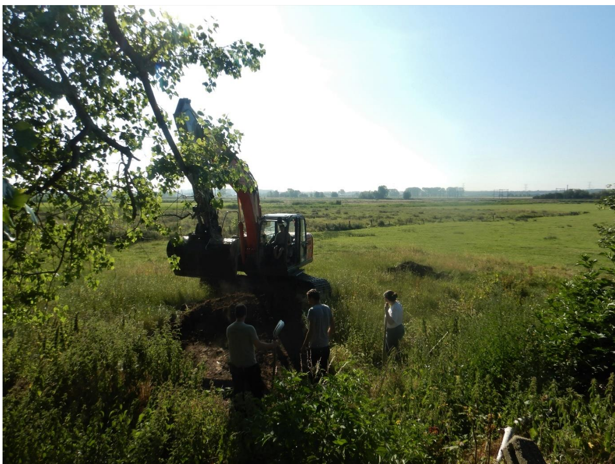
Figuur 6: Zicht op de polder tijdens de start van de graafwerken (zicht vanaf de kanaaldijk).
