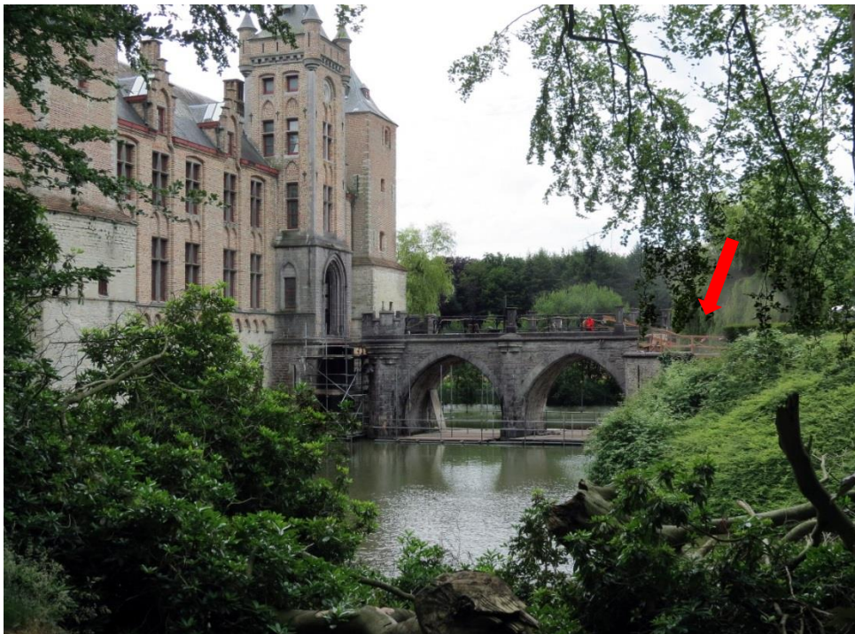
Figuur 24: Een zicht op de brug, aan de noordwestkant van het kasteel (Kasteel van Tillegem). De rode pijl wijst naar de werfput.
