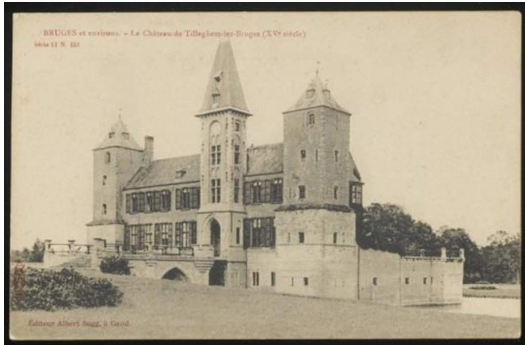
Figuur 21: Prentbriefkaart uit het einde van de 19de eeuw. Op deze foto is te zien dat de brug is opgewaardeerd en dat er een muur is gebouwd op het landhoofd. (Devliegheer 1989; beeldbankbrugge: GM-114-2)
