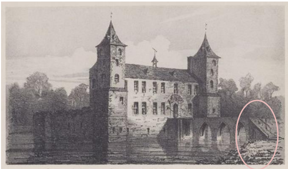
Figuur 19: In het midden van de 19 de eeuw bestaat de huidige muur die het landhoofd verstevigt nog niet. De brug heeft ook nog geen gekanteelde afrastering en halfronde erkers. De ophaalbrug is wel aanwezig. (Devliegheer 1989, litho 1854 + beeldbankbrugge: ALB-20-026)
