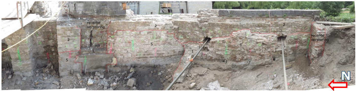
Figuur 30: Profiel Zuid, met aanduiding van de spoornummers (oostwand van de sleuf).
