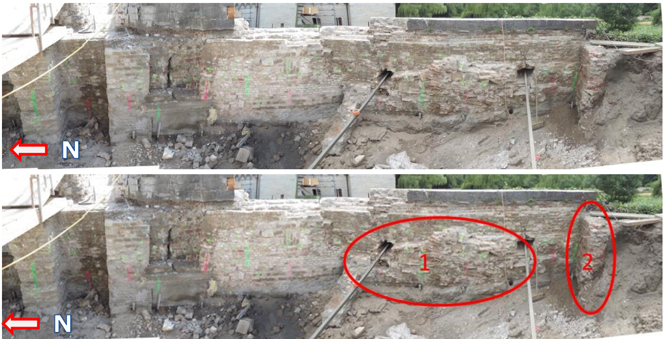
Figuur 26: : Foto van zuidkant van de blootgelegde muur, met ook de oudere muur zichtbaar (1), alsook een recente muur (2) die men al eerder bouwde ter ondersteuning van de muur waar de brug op rust.
