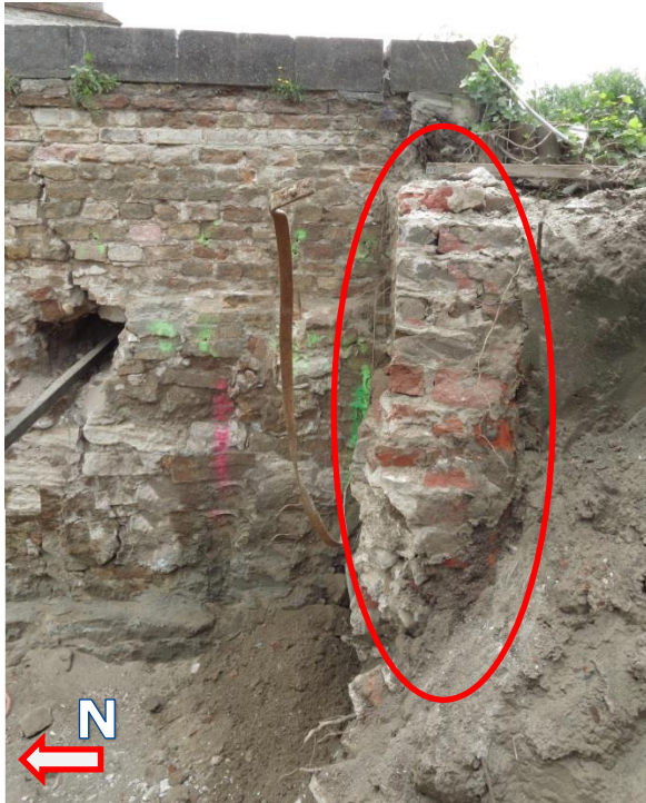
Figuur 29: Muur gebouwd met recente bakstenen, ter ondersteuning van de muur (sp 2) op het landhoofd op steunt (toevoeging uit de 20 ste eeuw).
