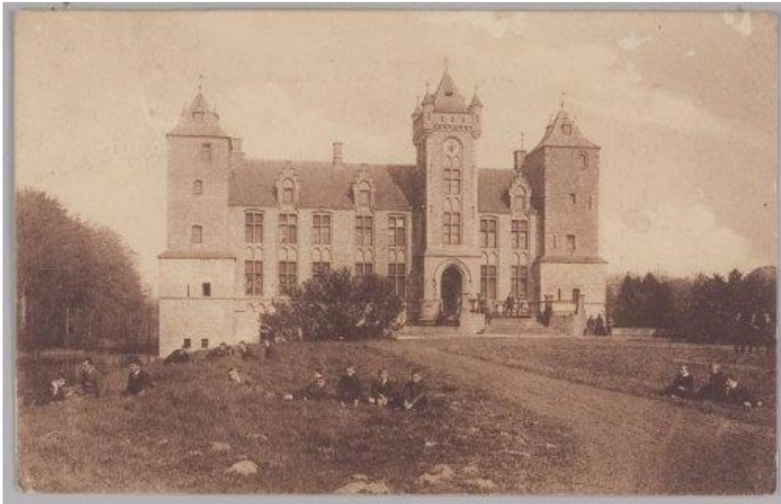
Figuur 22: Een zicht op de west-façade van het kasteel met de brug met twee gekanteelde halfronde erkers, een pseudo-ophaalbrug en een muur die het landhoofd verstevigt en waar de brug en de trap deels op rusten. (beeldbankbrugge: ALB-20-007)
