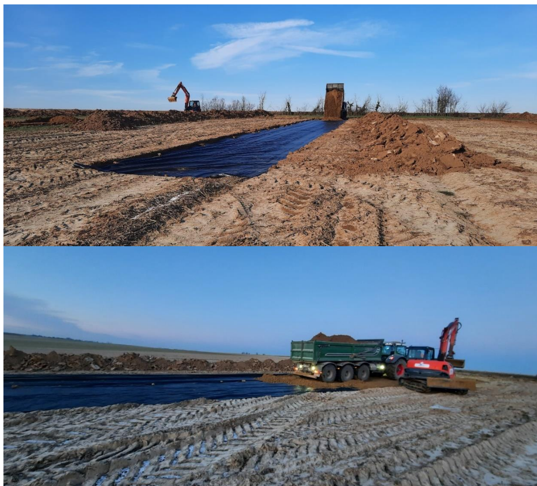
Figuur 8: aanvullen van de uitgegraven zones bovenop de geotextiel waarbij niet op het aangelegde vlak gereden werd.
