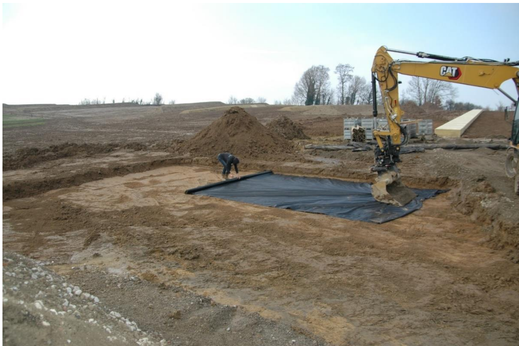
Figuur 7: plaatsen van geotextiel op het aangelegde vlak.
