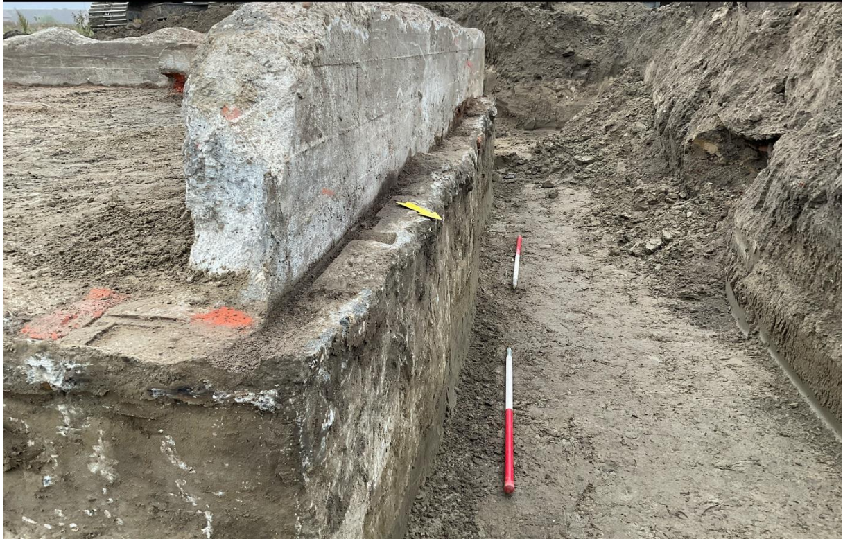
Figuur 45: fotografische opname van de noordzijde van de bunker met zicht op de fundering, de muur en de coffrage opbouw op de fundering.
