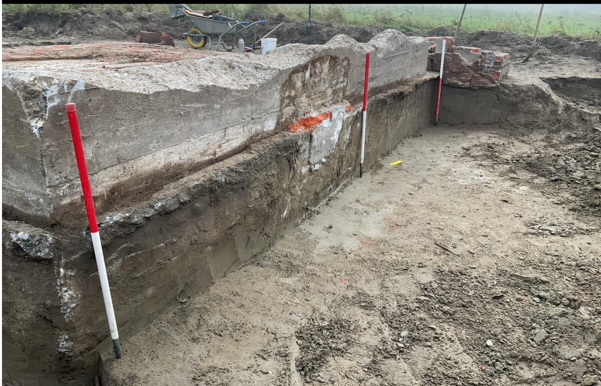
Figuur 44: fotografische opname van de westzijde van de fundering en het muurwerk met goed zichtbaar de afdrukken van de planken (horizontale lijnen).
