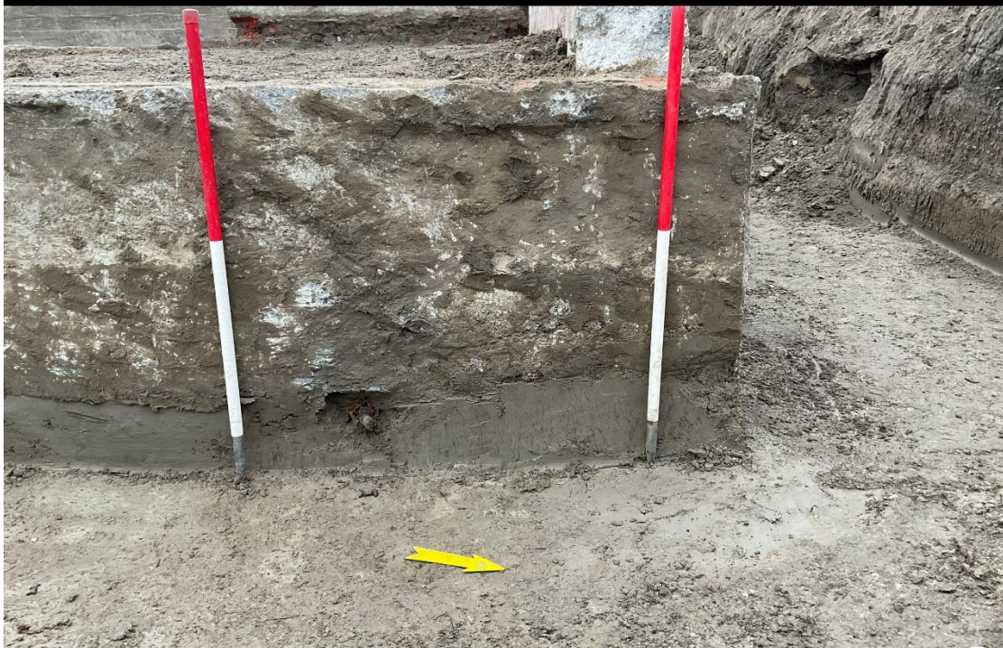
Figuur 31: fotografische opname van de kabel aan de oostzijde van de bunker, net onder de fundering.
