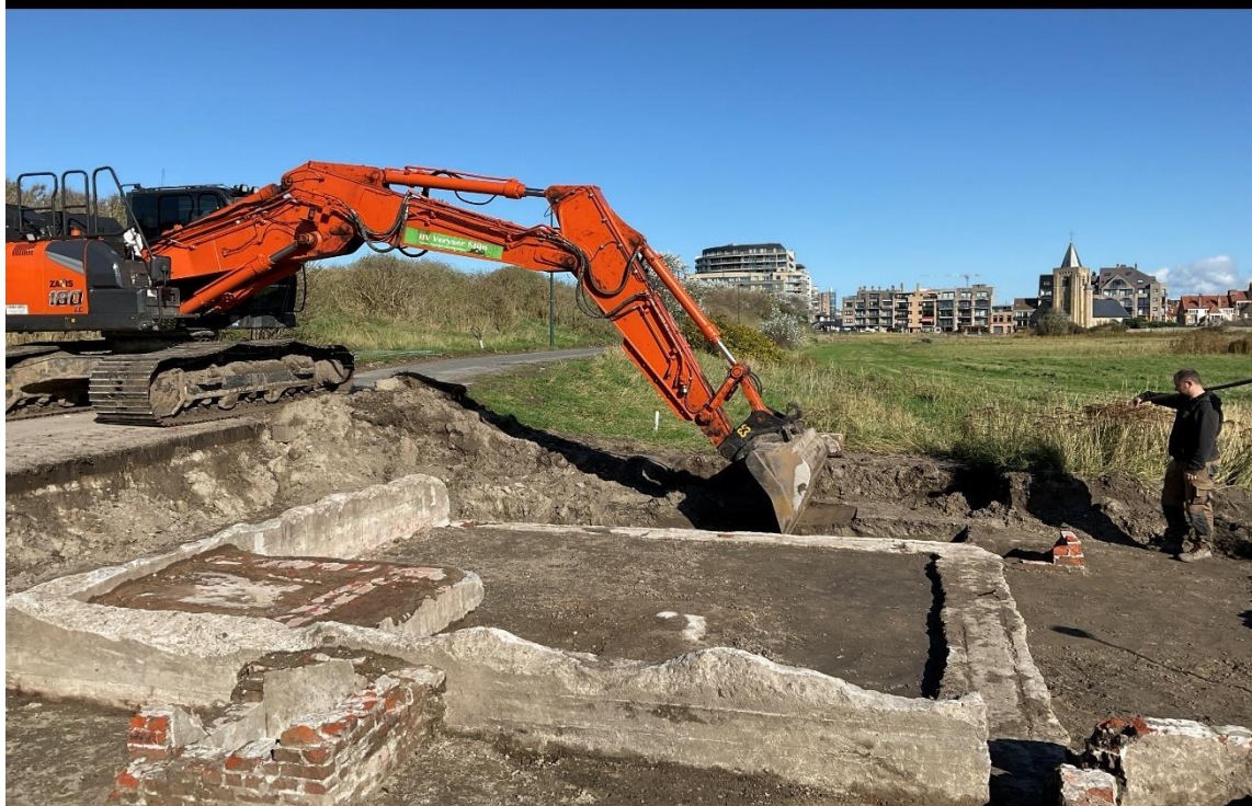
Figuur 14: fotografische opname van de afgraving met begeleiding.
