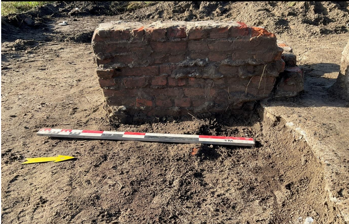
Figuur 63: fotografische opname van de oostelijke buitenzijde van spoor 10. Duidelijk zichtbaar is dat de constructie op de funderingsplaat van de bunker is gemetst.
