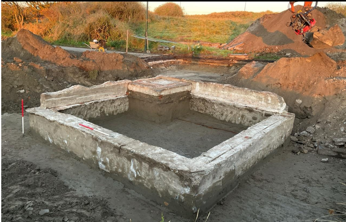
Figuur 40: fotografische opname van de fundering (S1) met enkel in het noorden en het westen nog een bestaande muur (S2).
