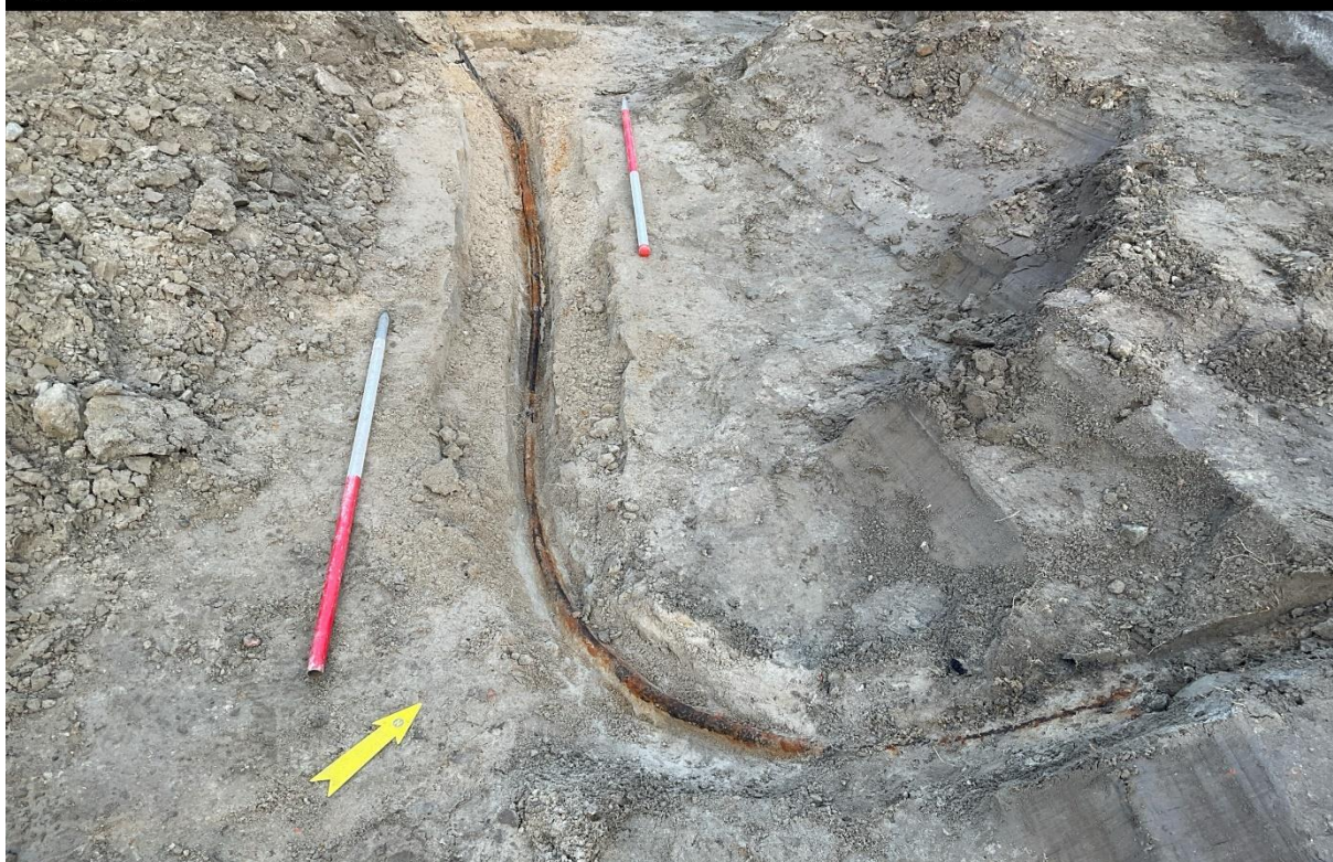
Figuur 55: fotografische opname van de kabel (S12) na afname van de beschermende bakstenen.
