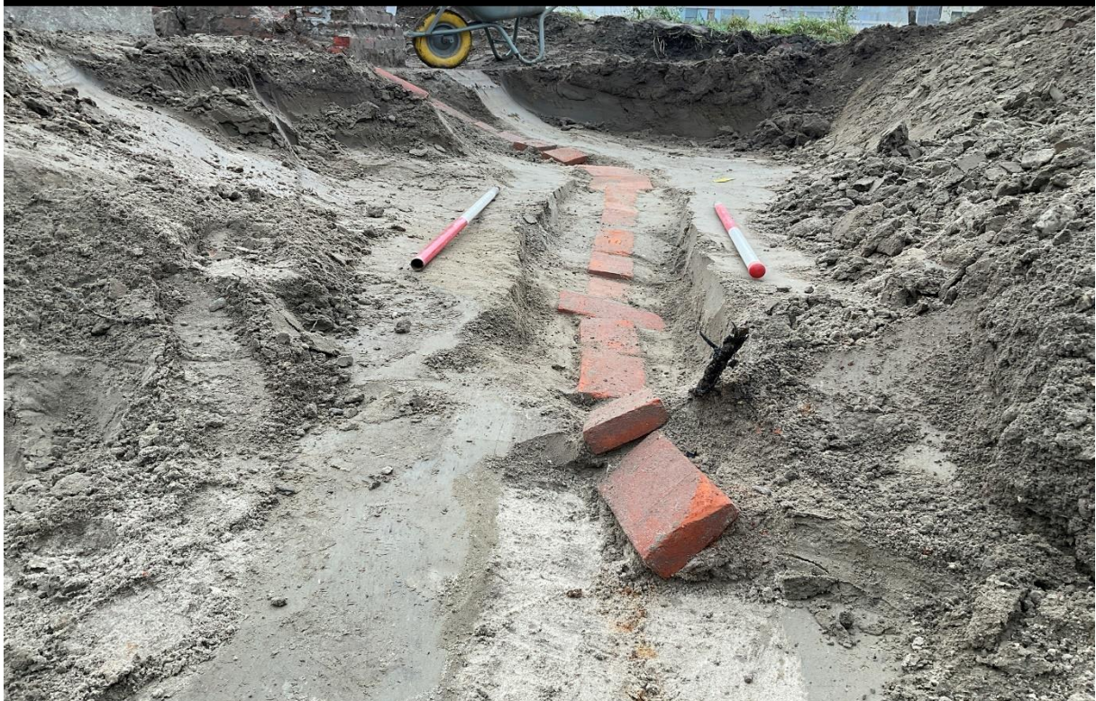
Figuur 54: fotografische opname van de kabel (S12) met de afdekking van bakstenen.
