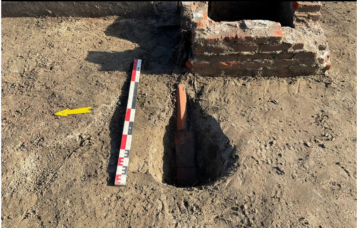
Figuur 52: fotografische opname van de communicatiekabel met bescherming in de vorm van bakstenen.
