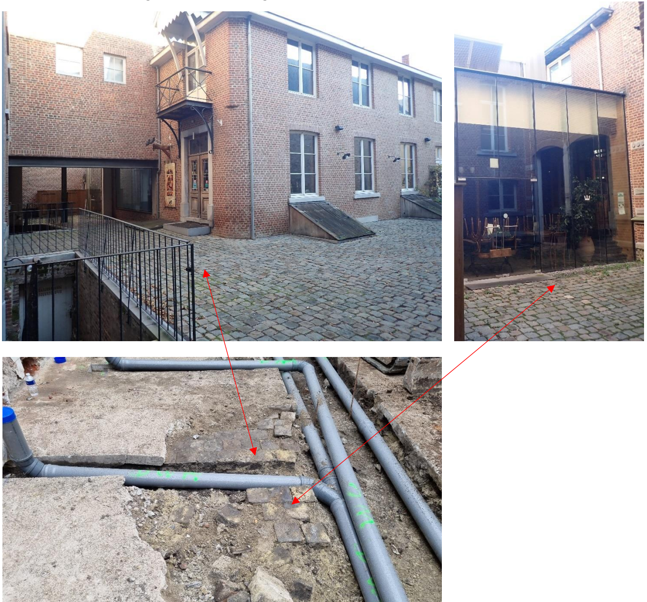
Fig. 31: zicht op de steeg ten westen van de projectzone en - andermaal - een detail van de kasseien onder de oude betonvloer
