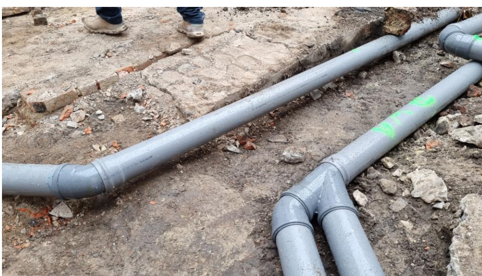
Fig. 15: de afvoerbuizen aan de oostzijde van het projectgebied waar een driehoekig vlak werd aangelegd
