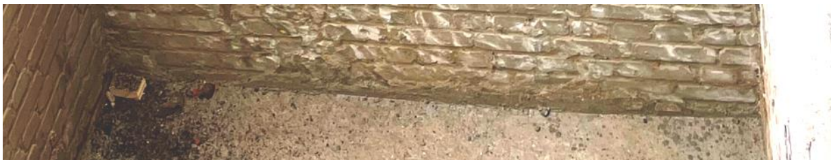
Fig. 29: aansluiting van de nieuwe betonvloer in het trappengat bij de bakstenen ommuring
