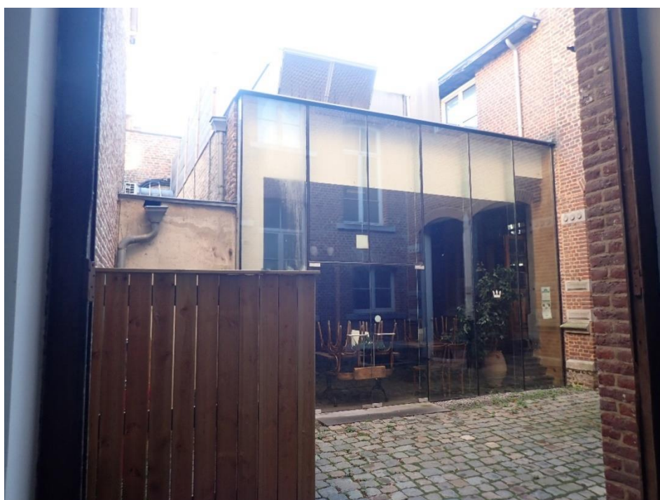
Fig. 23: De noordgevel van het ten zuiden aanpalend gebouw met links de plantput en aanduiding van de drie keldertoegangen waarvan de linkse (1) dichtgemetseld werd en het trappengat werd opgevuld (nu de plantput), centraal (2) een dichtgemetselde keldertoegang in het bestaande en tot liftkoker omgebouwde trappengat en rechts (3) de keldertoegang zoals die bestond tot voor de afbraak van de aanbouw in de projectzone.
