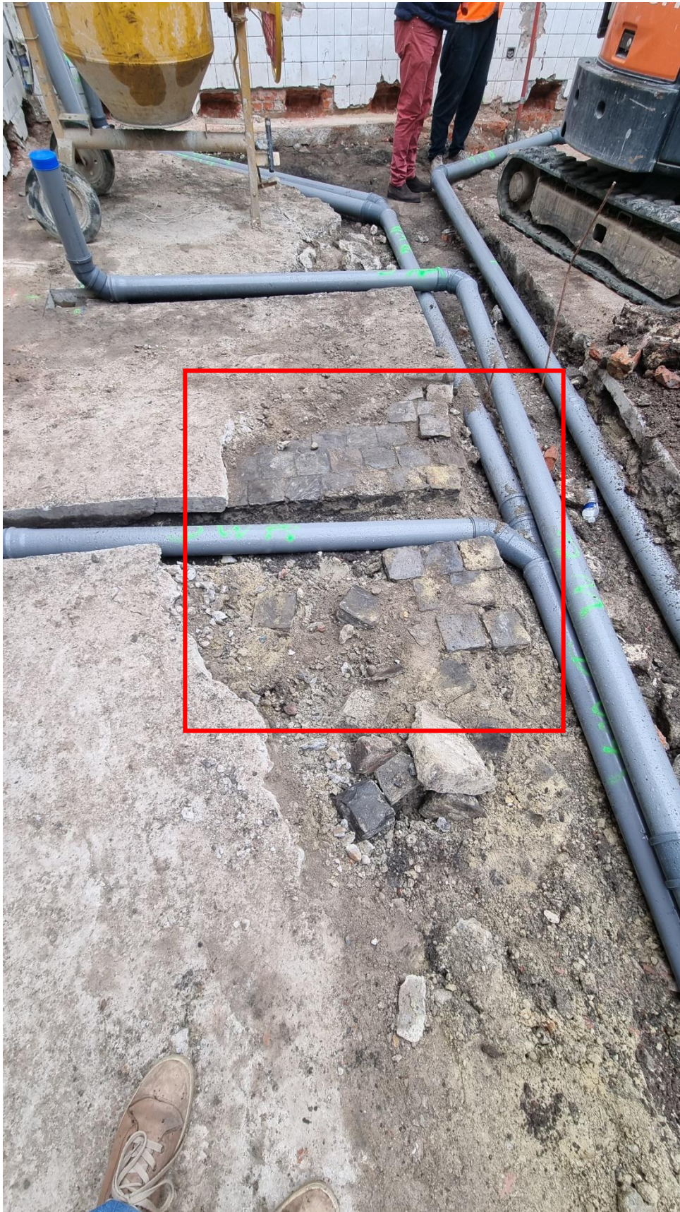
Fig. 5: de leidingensleuf met een klein deel van het gekasseide oppervlak onder de betonnen ondervloer
