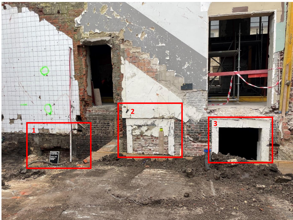
Fig. 23: De noordgevel van het ten zuiden aanpalend gebouw met links de plantput en aanduiding van de drie keldertoegangen waarvan de linkse (1) dichtgemetseld werd en het trappengat werd opgevuld (nu de plantput), centraal (2) een dichtgemetselde keldertoegang in het bestaande en tot liftkoker omgebouwde trappengat en rechts (3) de keldertoegang zoals die bestond tot voor de afbraak van de aanbouw in de projectzone.
