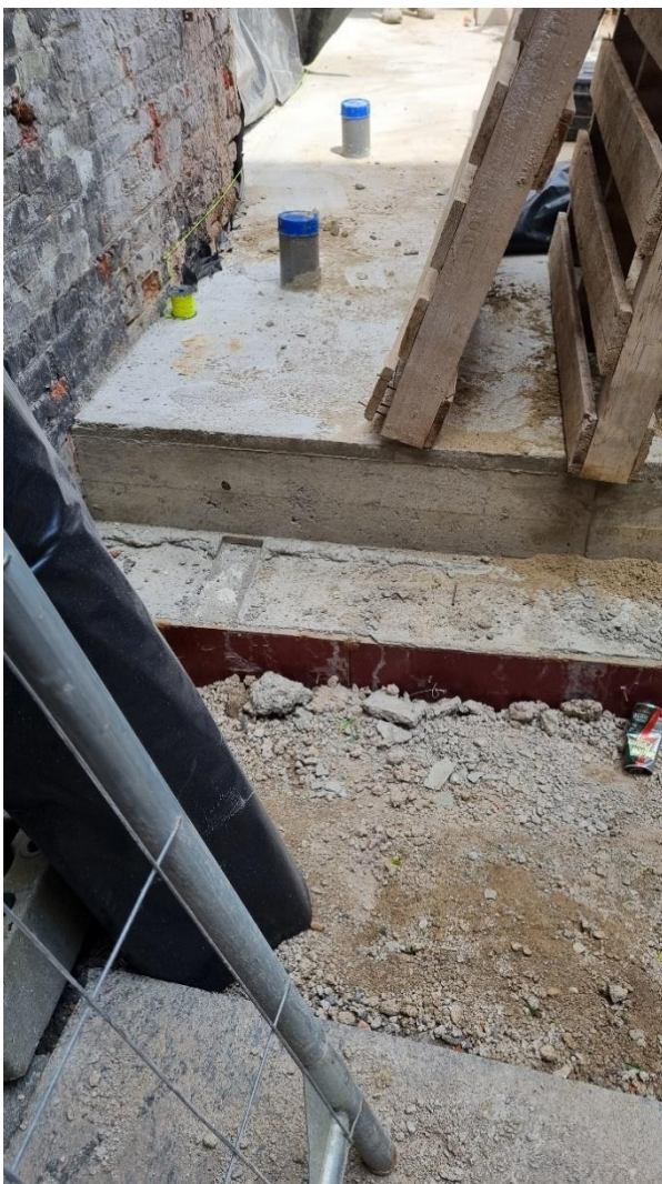
Fig. 30: detail van de nieuw gegoten betonvloer op de oude ondervloer met nog de afdruk van de tegels, de afwering van dat oude vloerniveau
