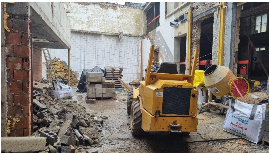
Fig. 11: het terrein zoals aangetroffen op 7/05/2024
