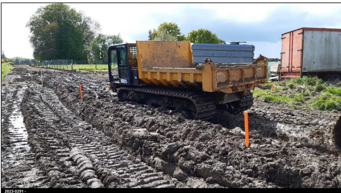
Figuur 24: Zicht op het niet op te volgen stukje tussen werkput 2 en 3. De hele strook was zeer modderig en diep verstoord door het gebruik van zware machines.
