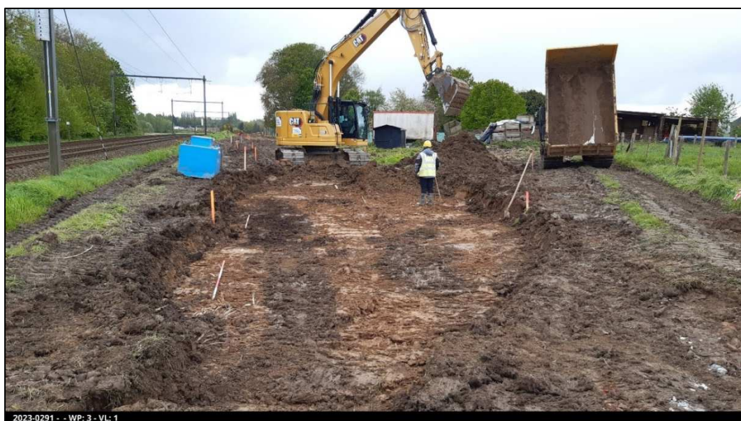
Figuur 22: Zicht op het zuiden van werkput 3 vanuit het noorden, verstoorte moederbodem door de natte omstandigheden.
