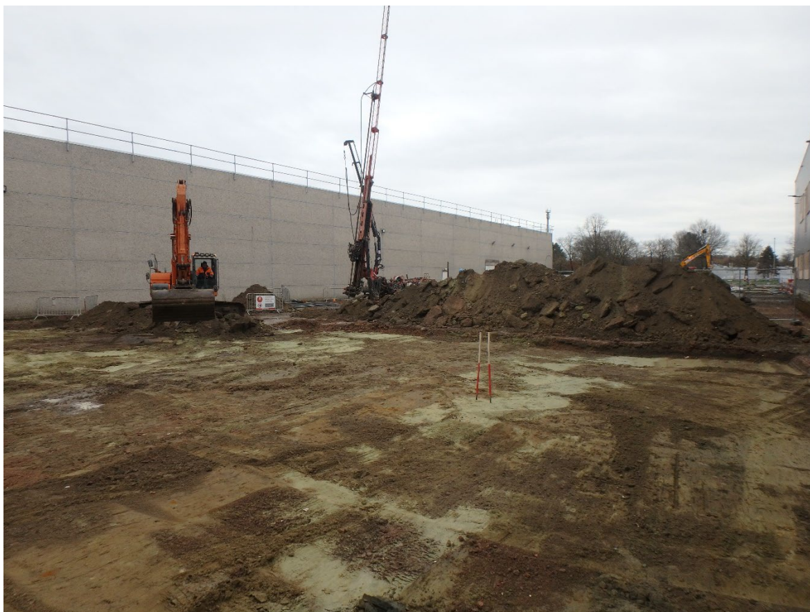
Figuur 3: Verwijderen van de steenslag.
