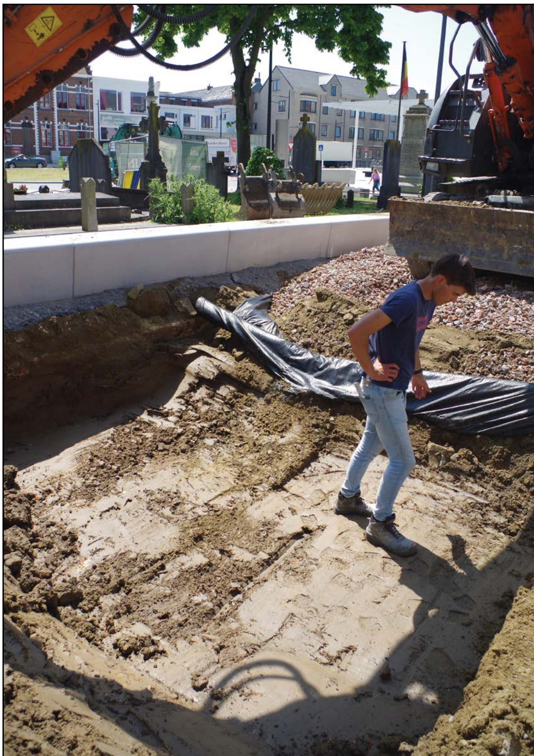
Fig. 61. Zone IV ter hoogte van het toegangspad tot de kerk.
