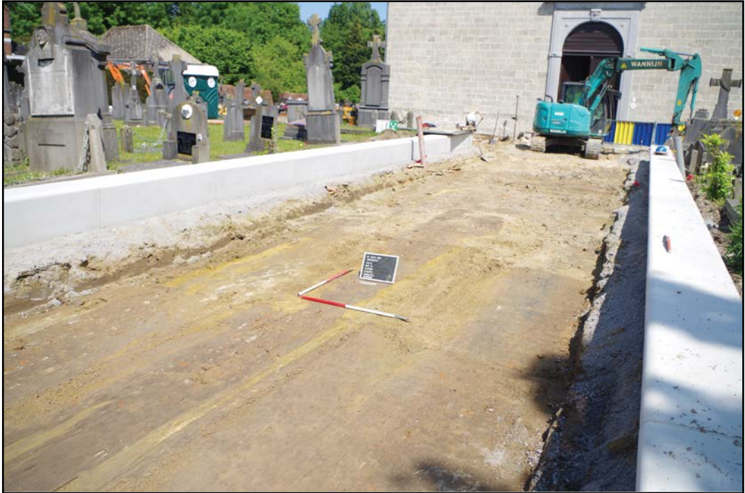
Fig. 58. Zone IV ter hoogte van het toegangspad tot de kerk.
