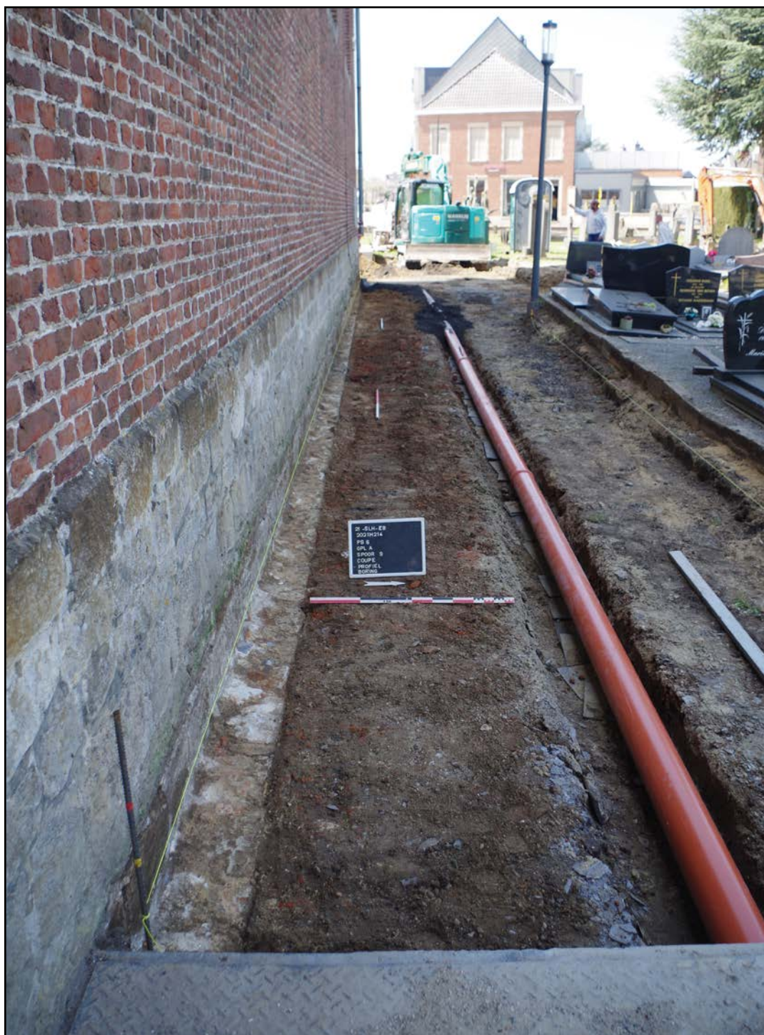
Fig. 92. Zicht op het verstek van de fundering van de huidige kerk aan de noordzijde.
