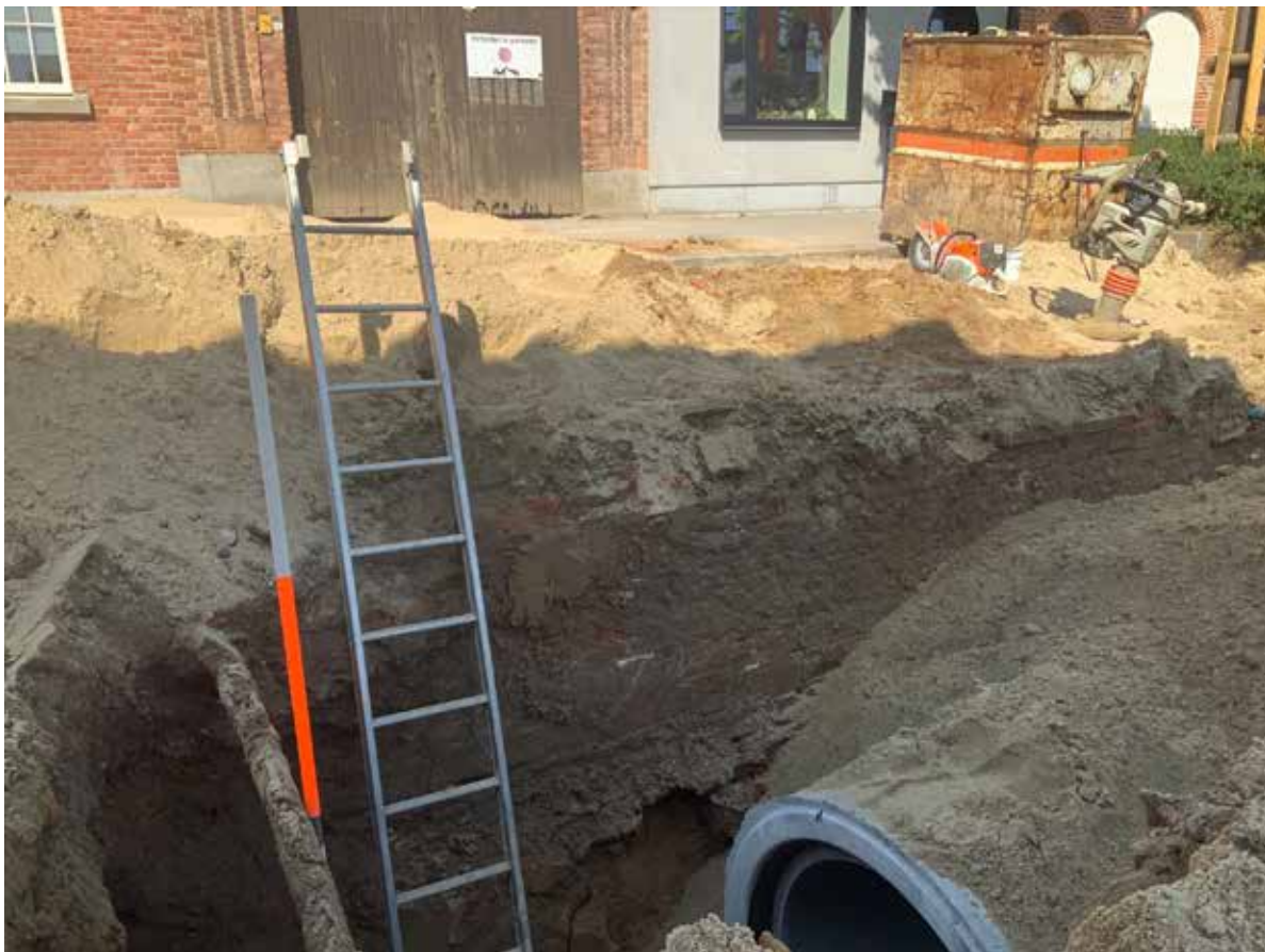
Figuur 79: Foto tijdens de rioleringswerken van 2022. De noord-zuidgerichte muur met natuurstenen plint en brokkelige fundering eronder is zichtbaar.
