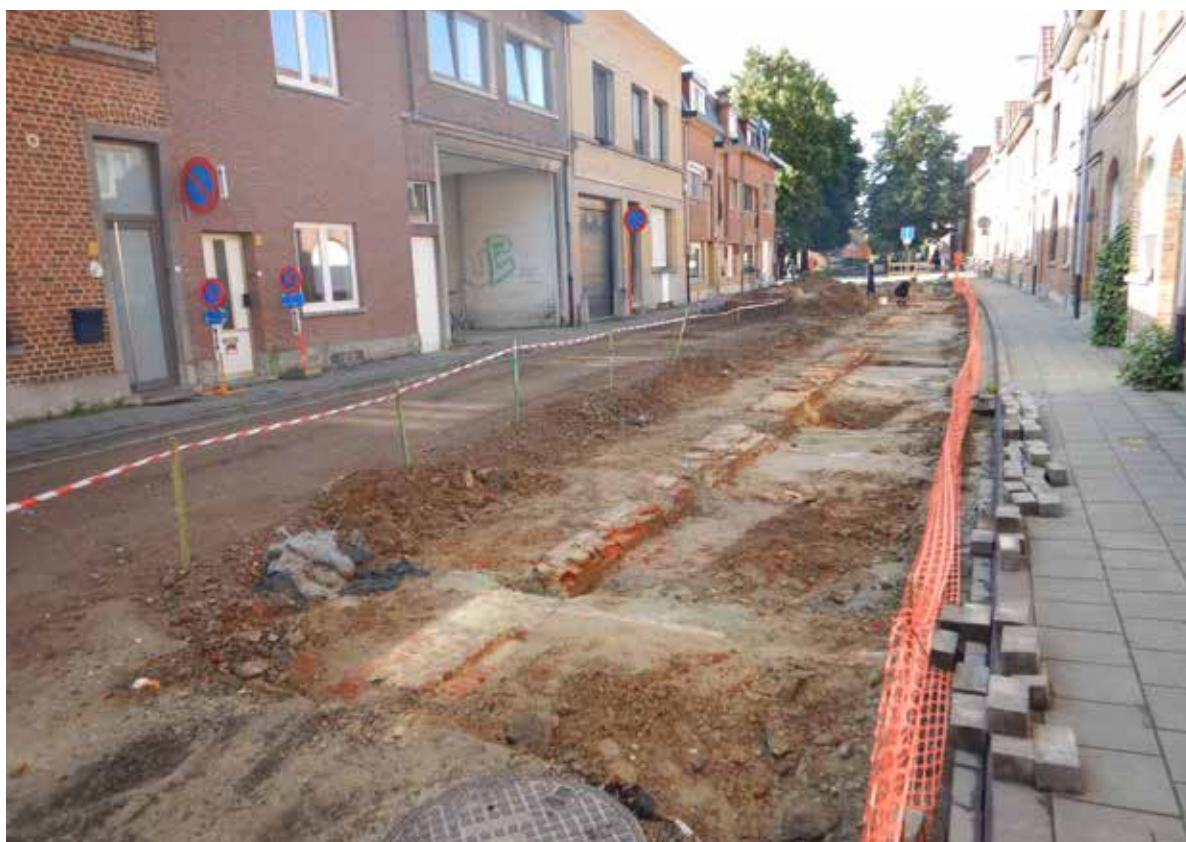
Figuur 46: Overzicht WP1. Foto vanuit het noorden met op de voorgrond S10.
