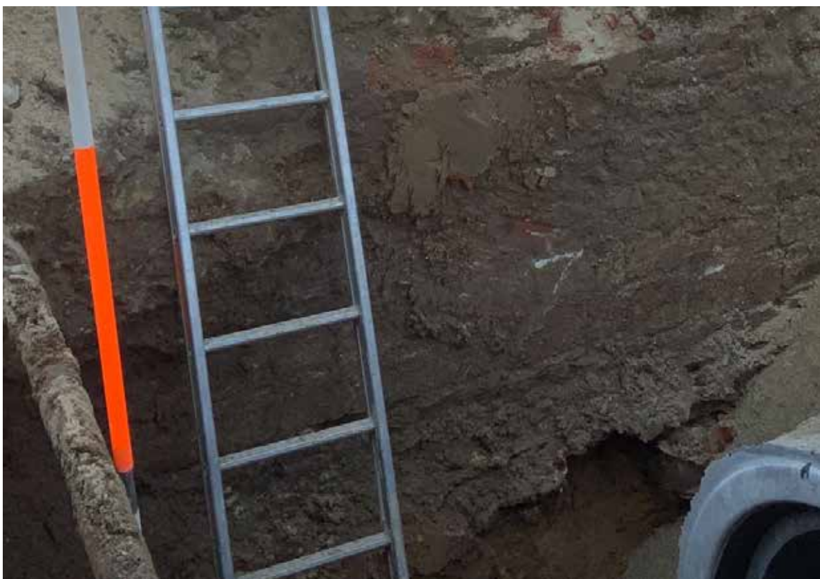
Figuur 80: Detail van hierboven. De natuurstenen zijn herkenbaar door de enkele witte strepen (waar de kraan de stenen raakte) en de voegen die zich hier verder van elkaar bevinden dan bij de bakstenen erboven.
