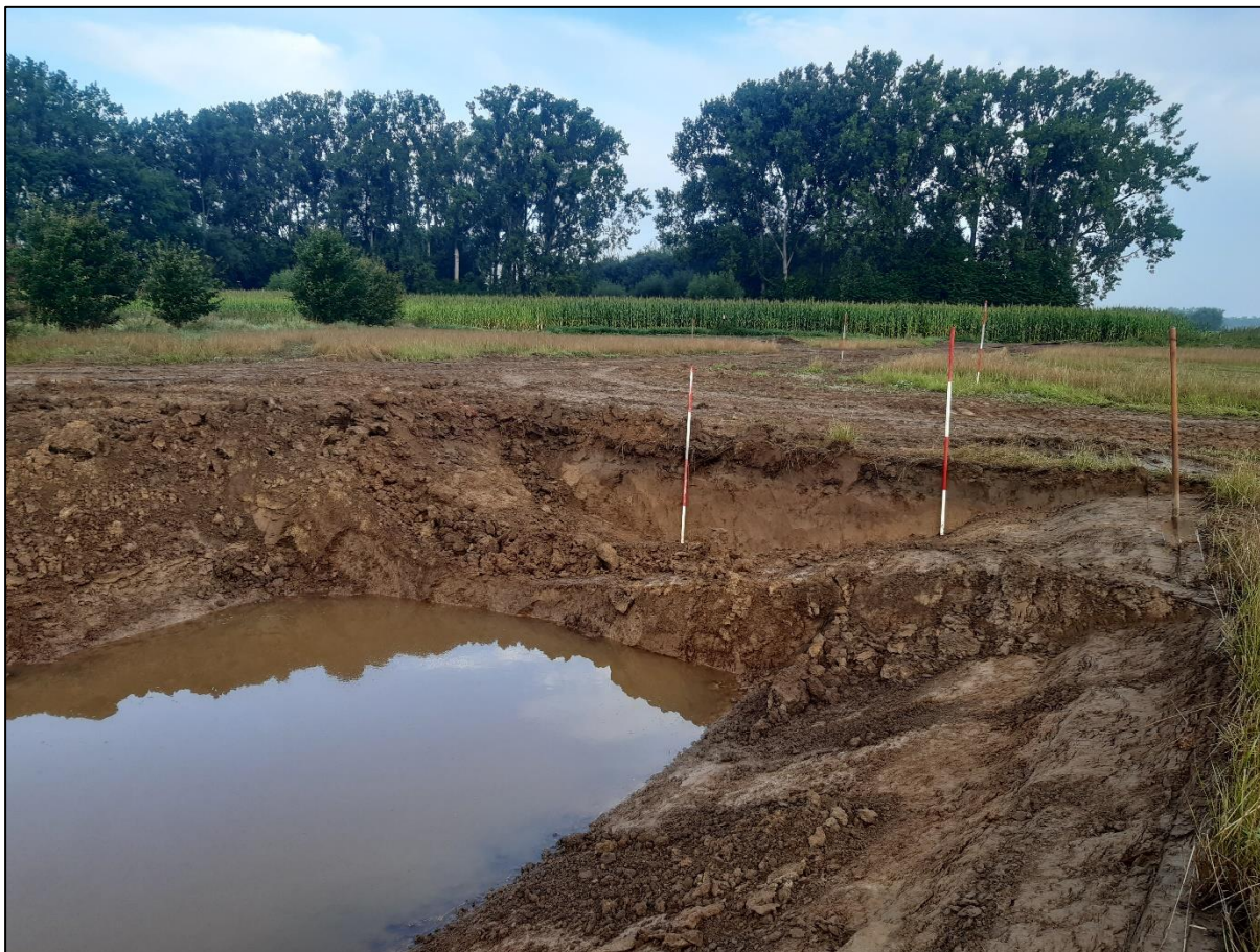
Figuur 9: Aangelegd profiel 2.6 ter hoogte van uitgraving oude meanderloop, perceelsgrens 65 en 457A.
