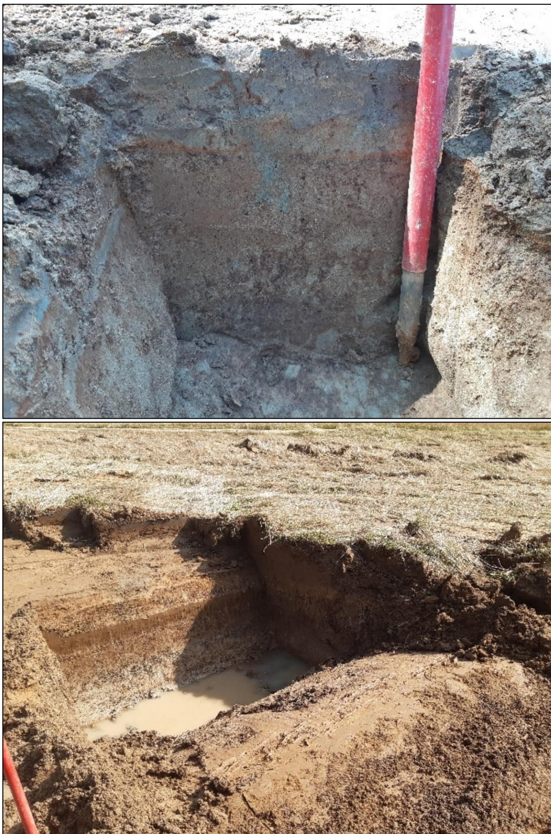
Figuur 8: Werkmethodiek: manuele aanleg controleputjes diepte afgraving (boven) of machinale aanleg profielputten (onder).
