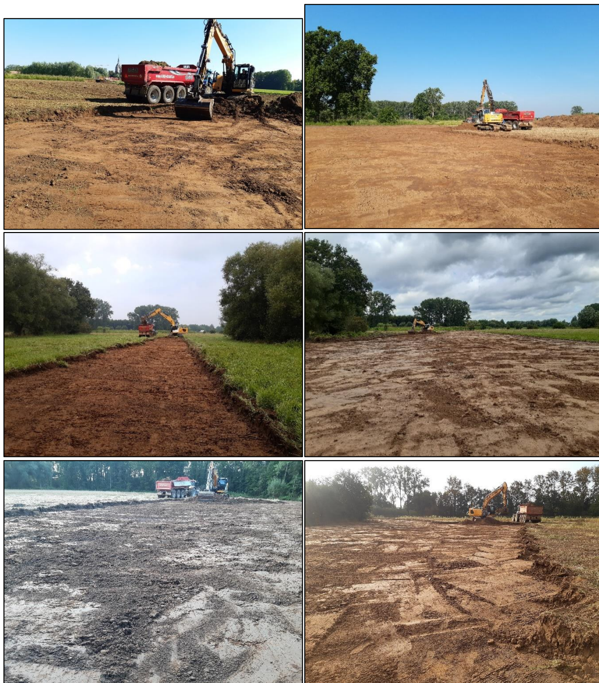
Figuur 7: Werkmethodiek: machinale afgraving bodem.
