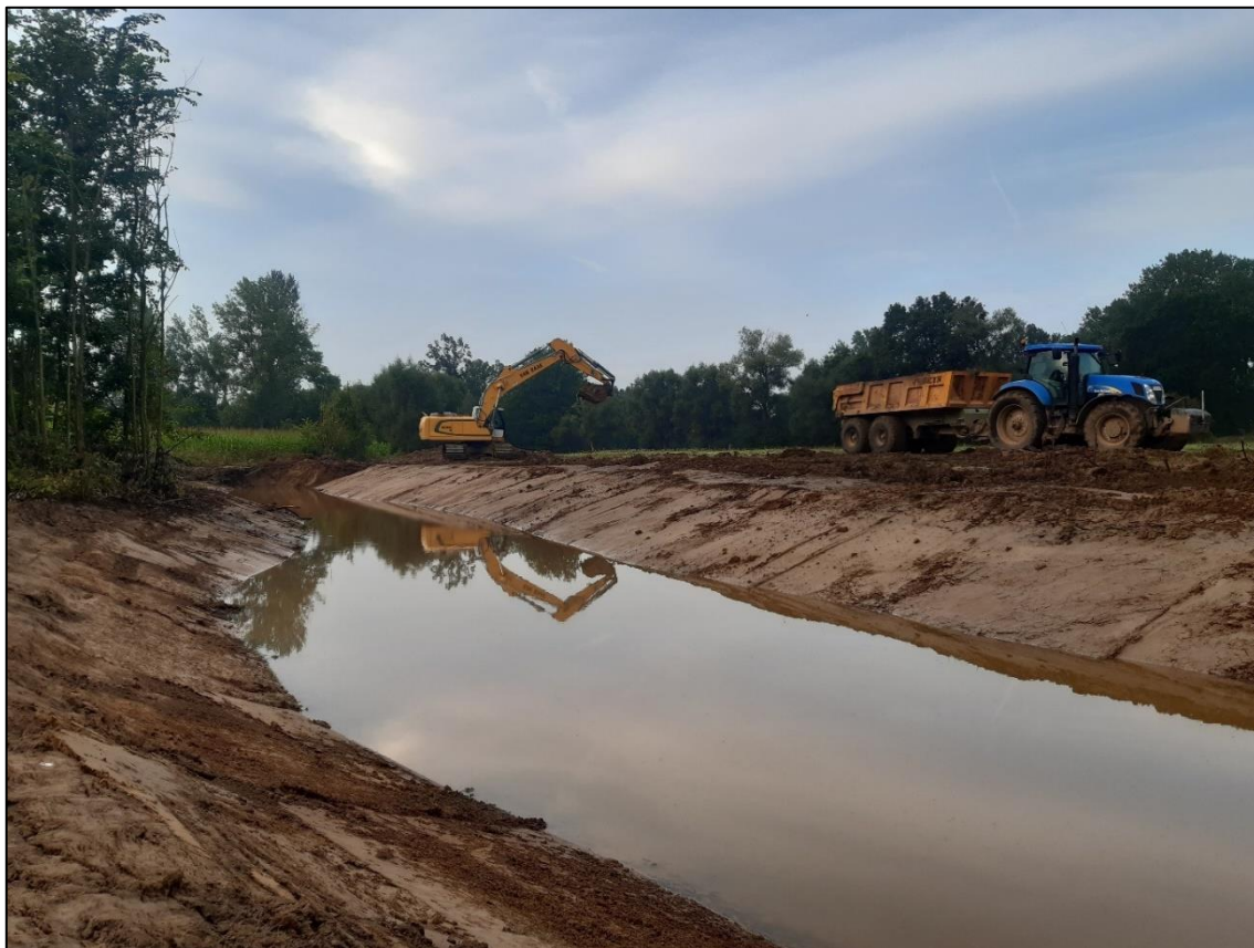
Figuur 17: Uitgraving oude meanderloop ter hoogte van percelen 65 , 456 en 457A.
