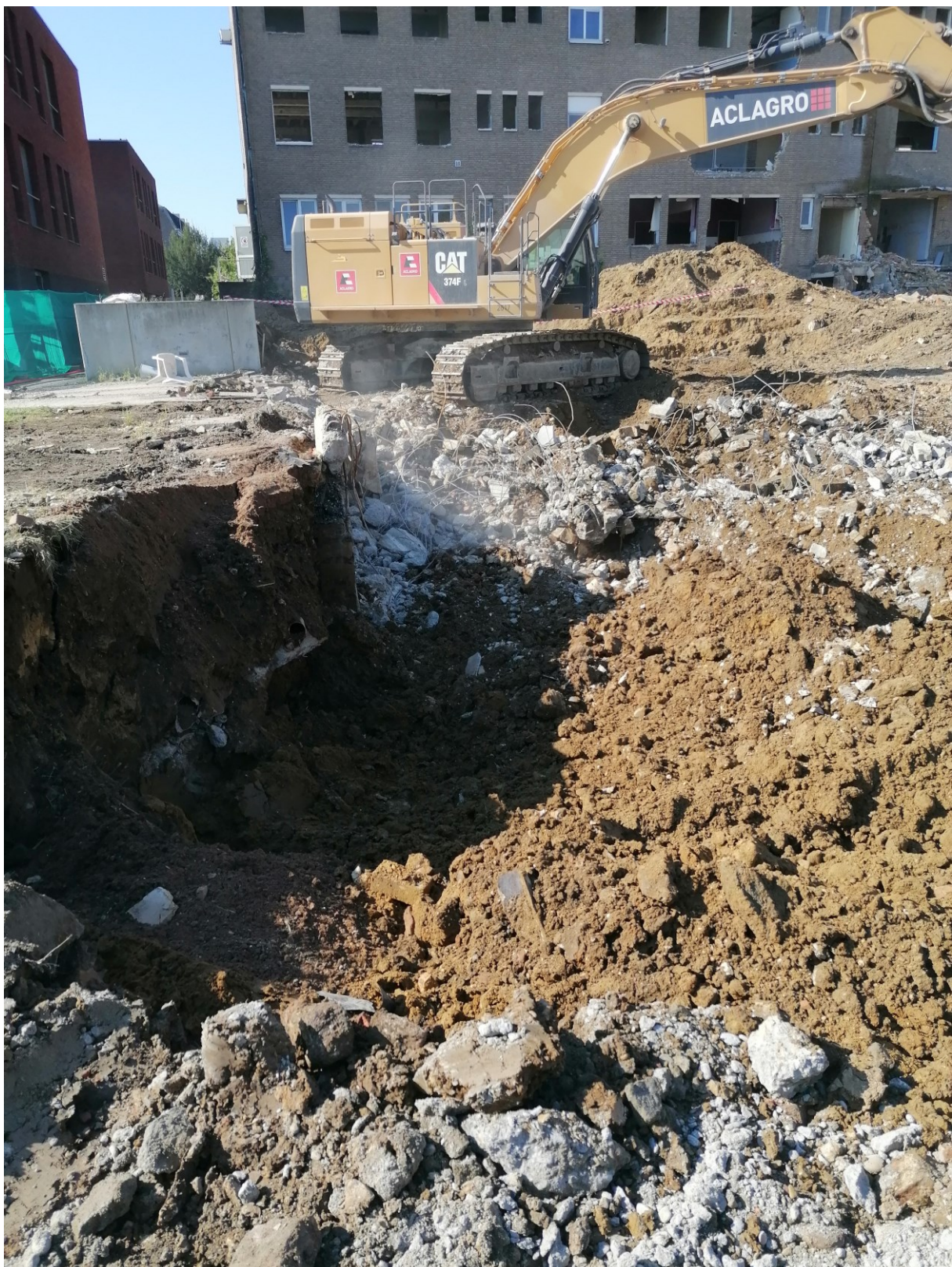
Figuur 24: foto 1: ontgraving vloerplaat zone 1 (23/04, ABO nv)
