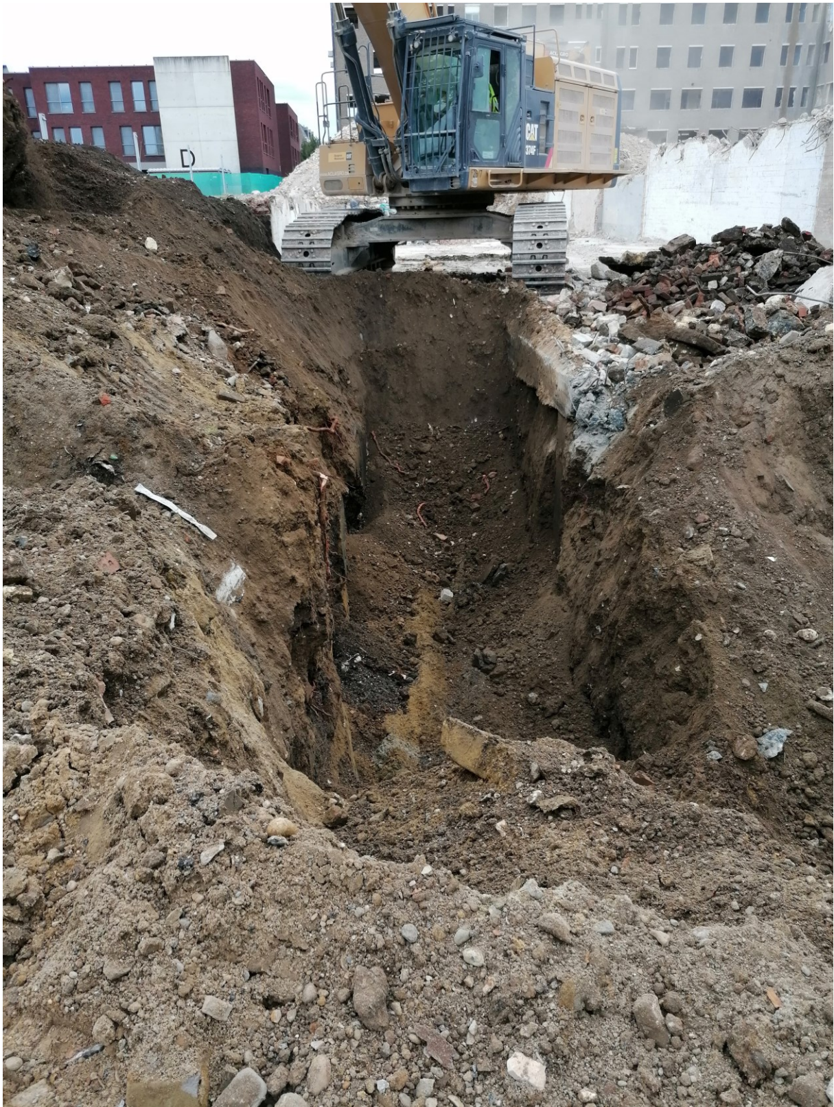
Figuur 28: foto 5: ontgraving funderingszolen en profiel zijwand zone 2 (29/04, ABO nv)
