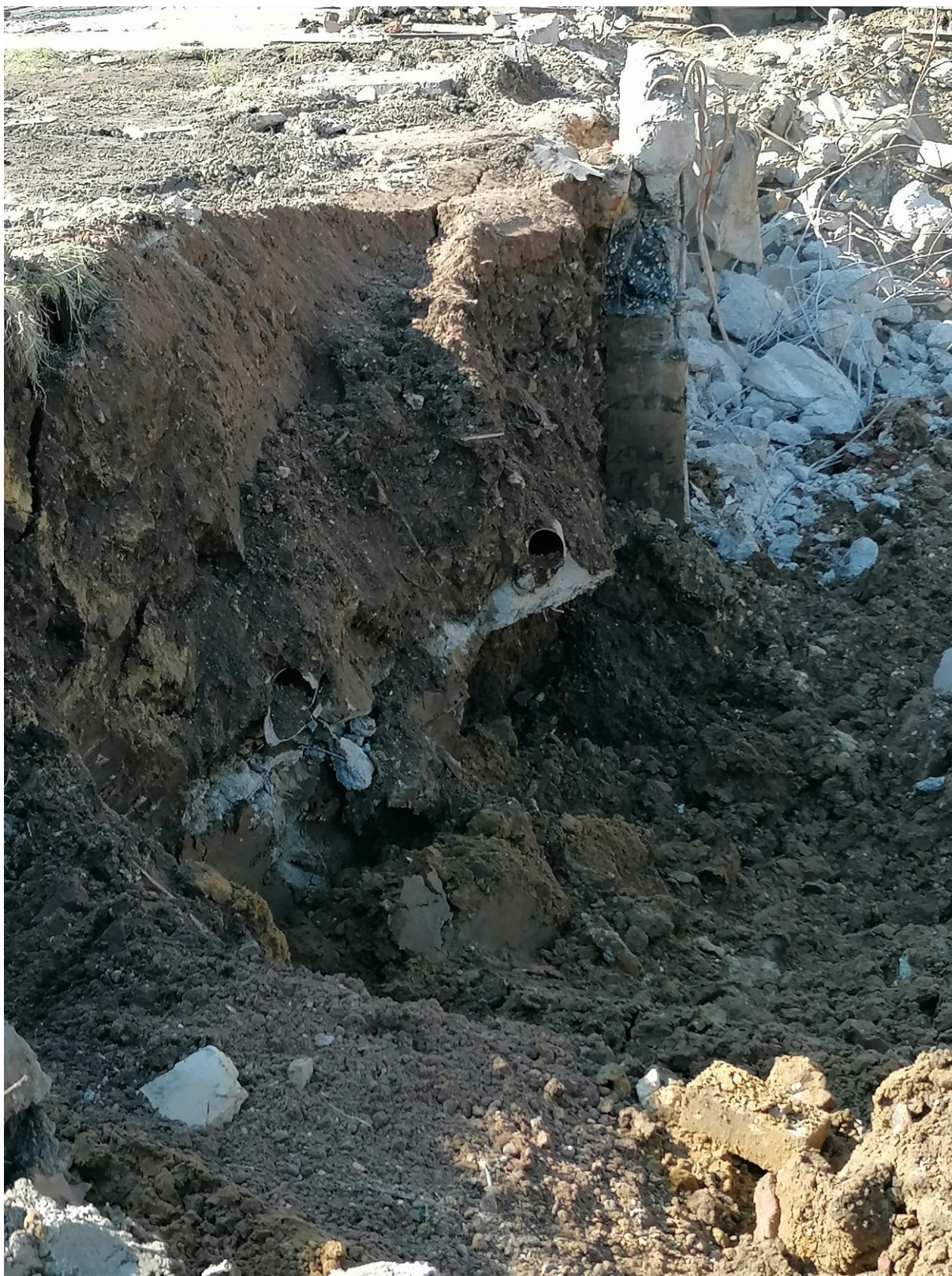
Figuur 25: foto 2: ontgraving vloerplaat en profiel zijwand zone 1 (23/04, ABO nv)
