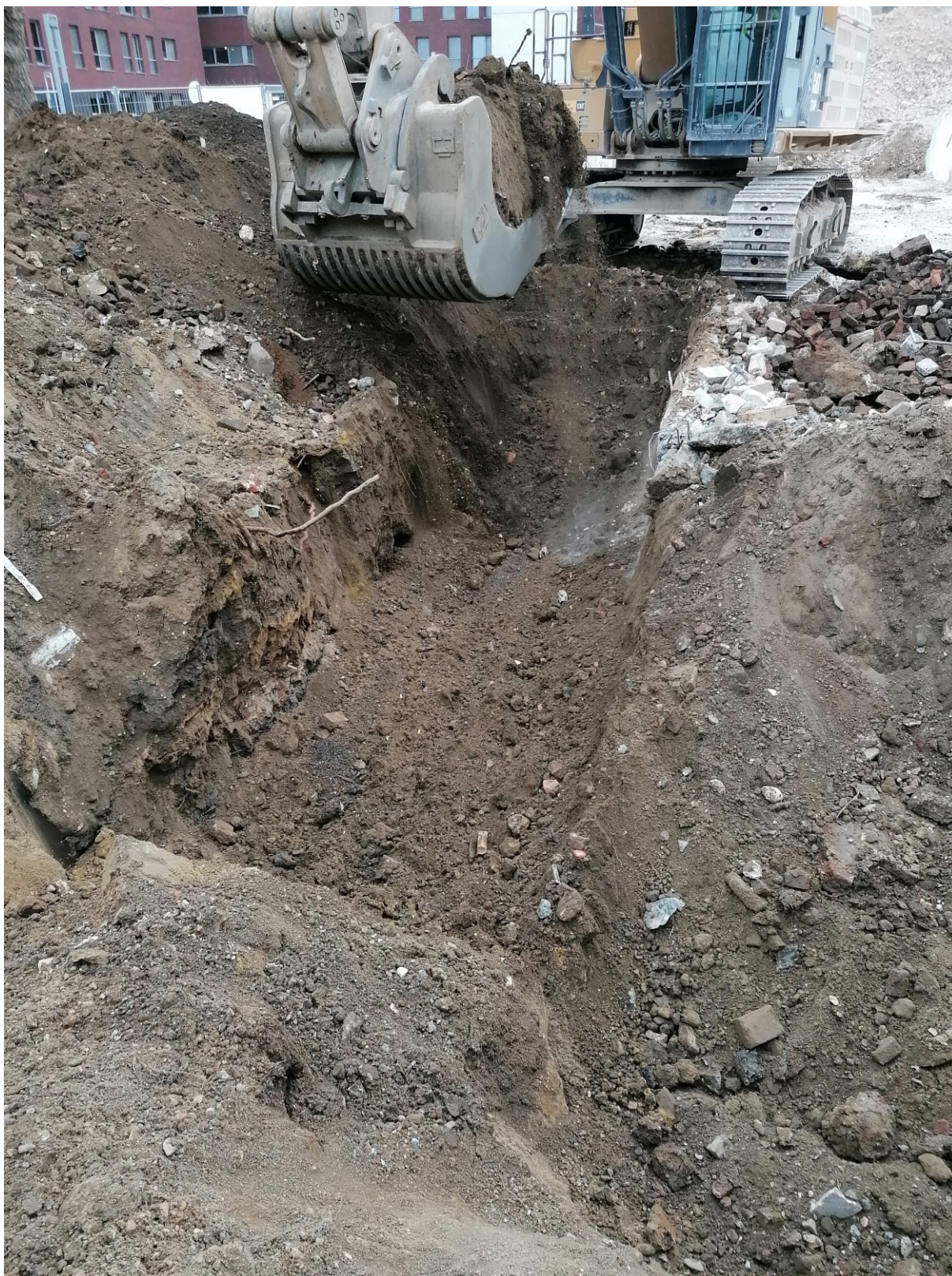
Figuur 27: foto 4: ontgraving vloerplaat en profiel zijwand zone 2 (29/04, ABO nv)
