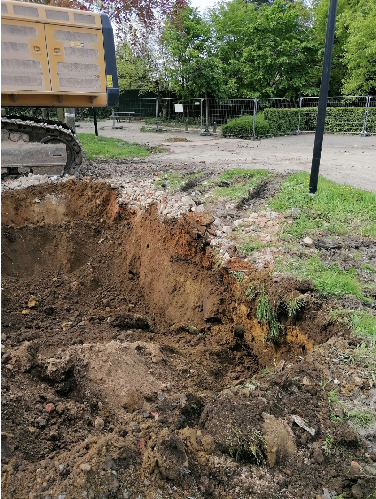
Figuur 26: foto 3: ontgraving vloerplaat en profiel zijwand zone 2 (29/04, ABO nv)
