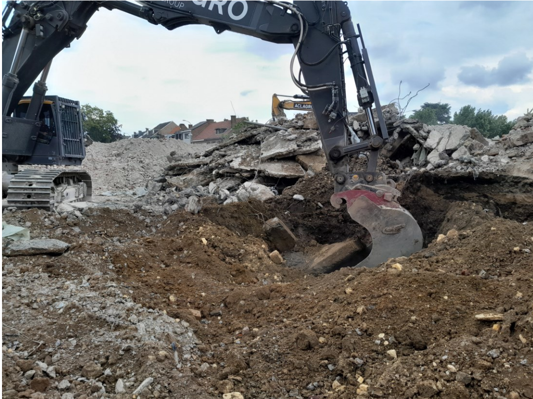
Figuur 29: foto 6: ontgraving funderingszool en profiel zone 3 (30/05, ABO nv)
