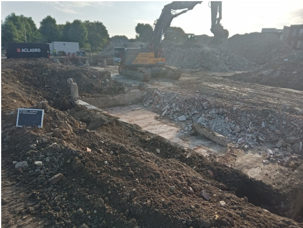
Figuur 31: foto 8: ontgraving vloerplaat dieperliggende kelder zone 4 (10/06, ABO nv)
