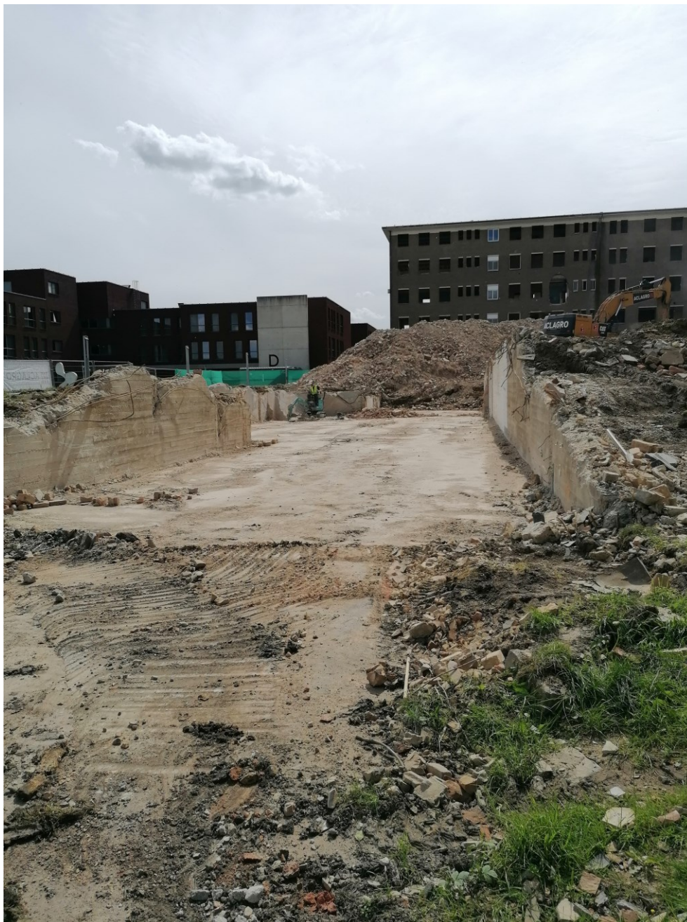
Figuur 18: Zicht op de kelder in zone 2 (rusthuis), oriëntatie van noord naar zuid. De vloer van de kelder ligt gelijk met de berm (ABO nv, 29/04/2024).
