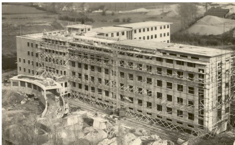
Figuur 10: Foto van de bouw van het ziekenhuis anno 1954 (Documentatiecentrum Maaseik)
