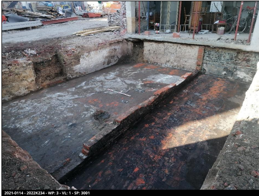
Figuur 36: Uitgegraven kelder in werkput 3 (S3001)
