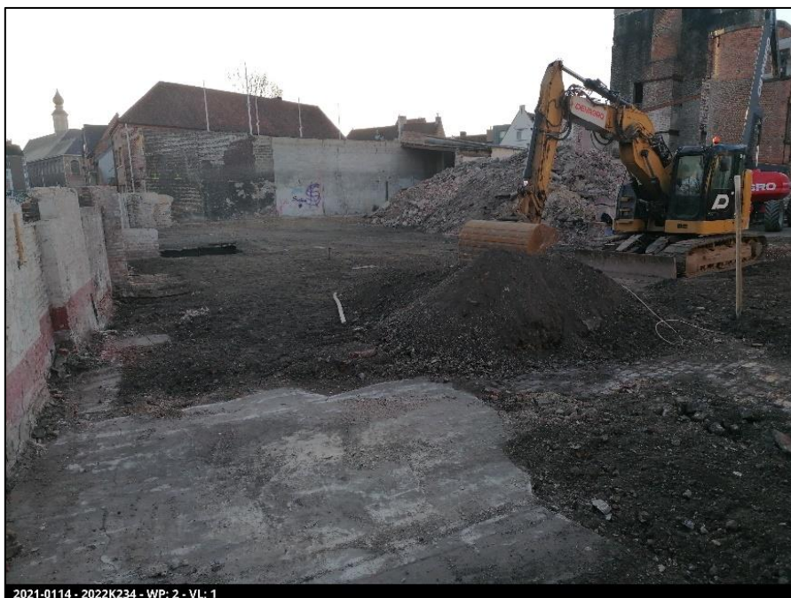
Figuur 9: Zicht op werkput 2 (Zone B) richting oosten.
