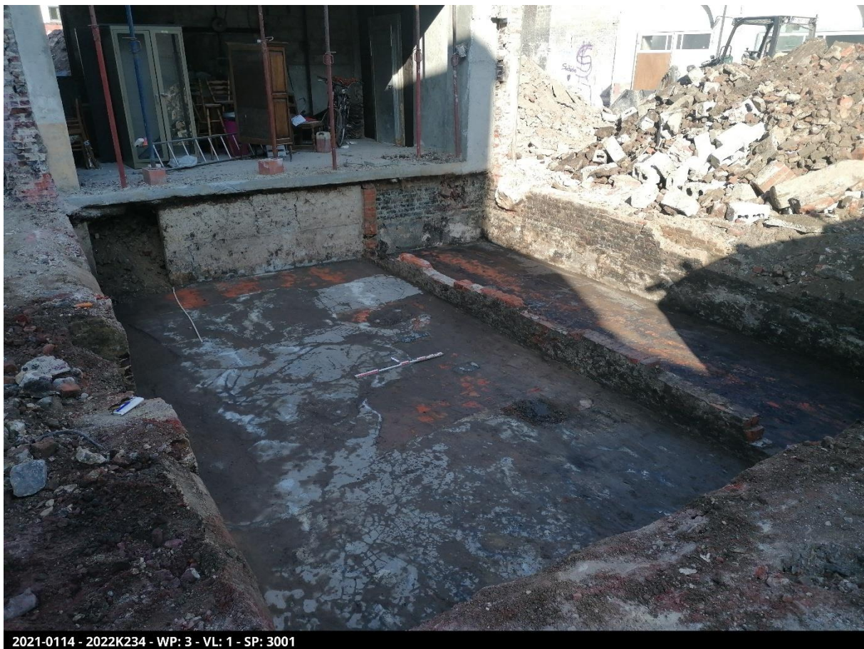
Figuur 26: Uitgegraven kelder S3001, ten zuiden van het ketelhuis.
