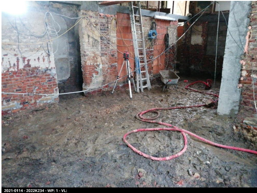
Figuur 22: Kelder binnen Zone A na verwijderen cementvloer.
