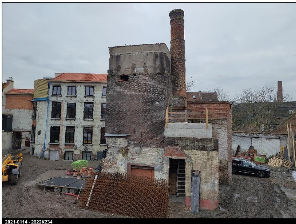
Figuur 11: Zicht op het ketelhuis (zone E) richting westen.
