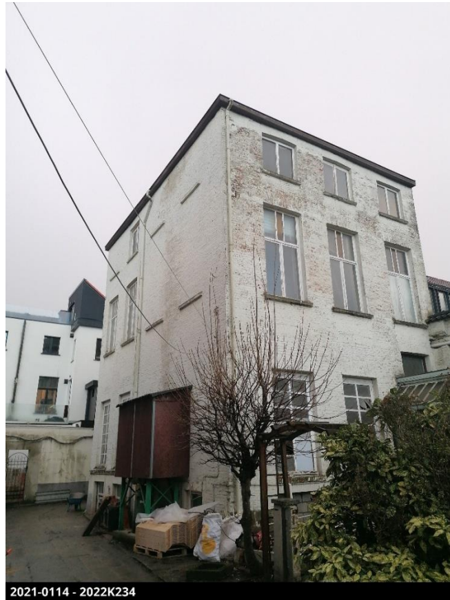
Figuur 20: Zone A: het te renoveren pand voor de start van het onderzoek.
