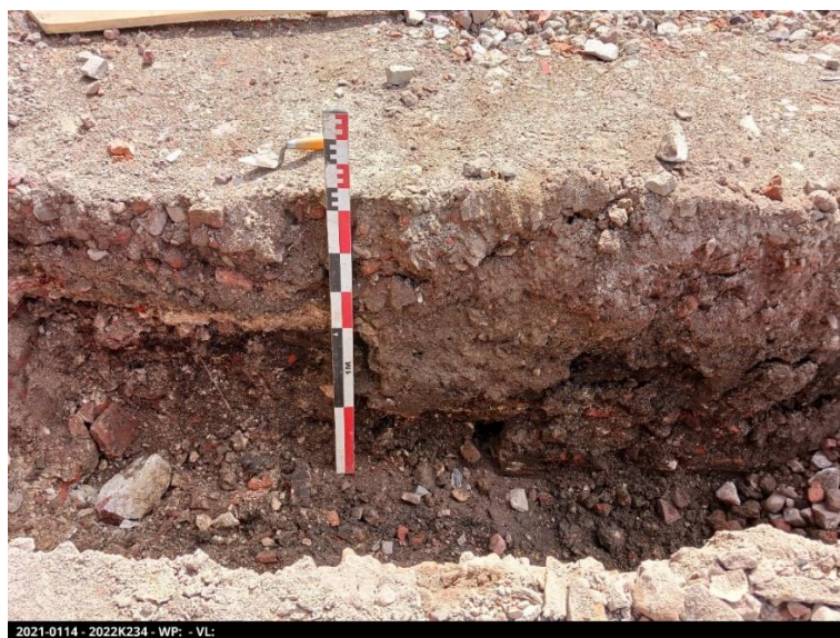
Figuur 25: Aanleg nutsvoorzieningen binnen zone B, met de duidelijk aanwezige puinlaag.
