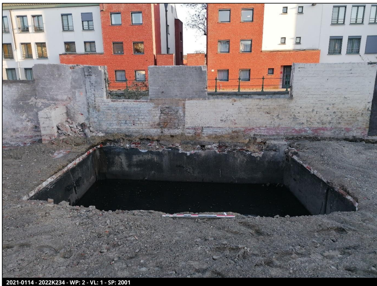
Figuur 35: Kelder (S2001) in het noorden van het plangebied
