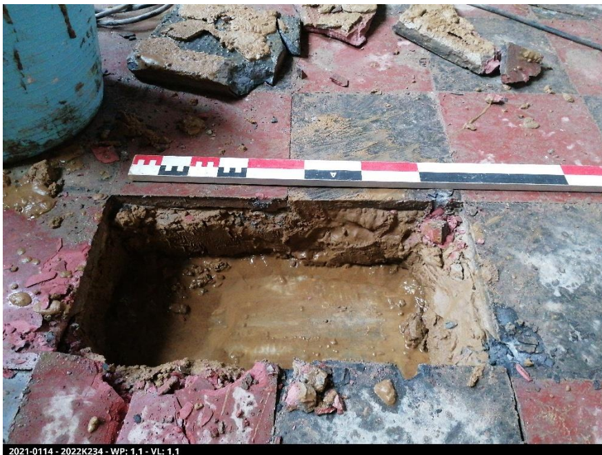
Figuur 21: Uitgraven van de bestaande 20e eeuwse vloer tot op cementlaag.
