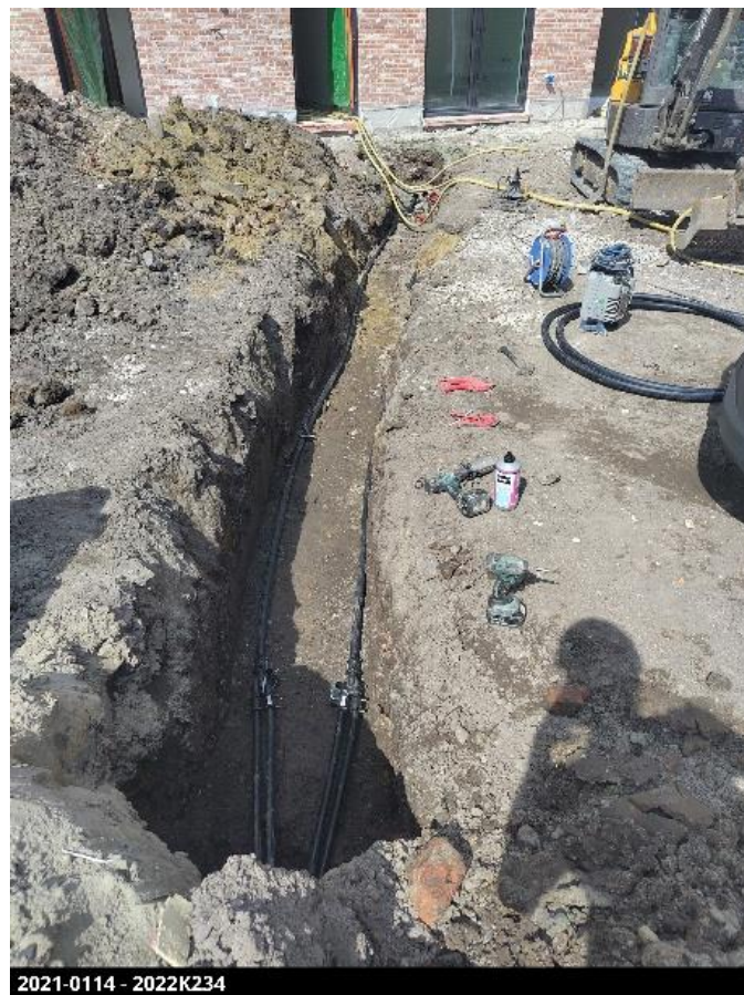
Figuur 12: aanleg sleuven voor geothermie.
