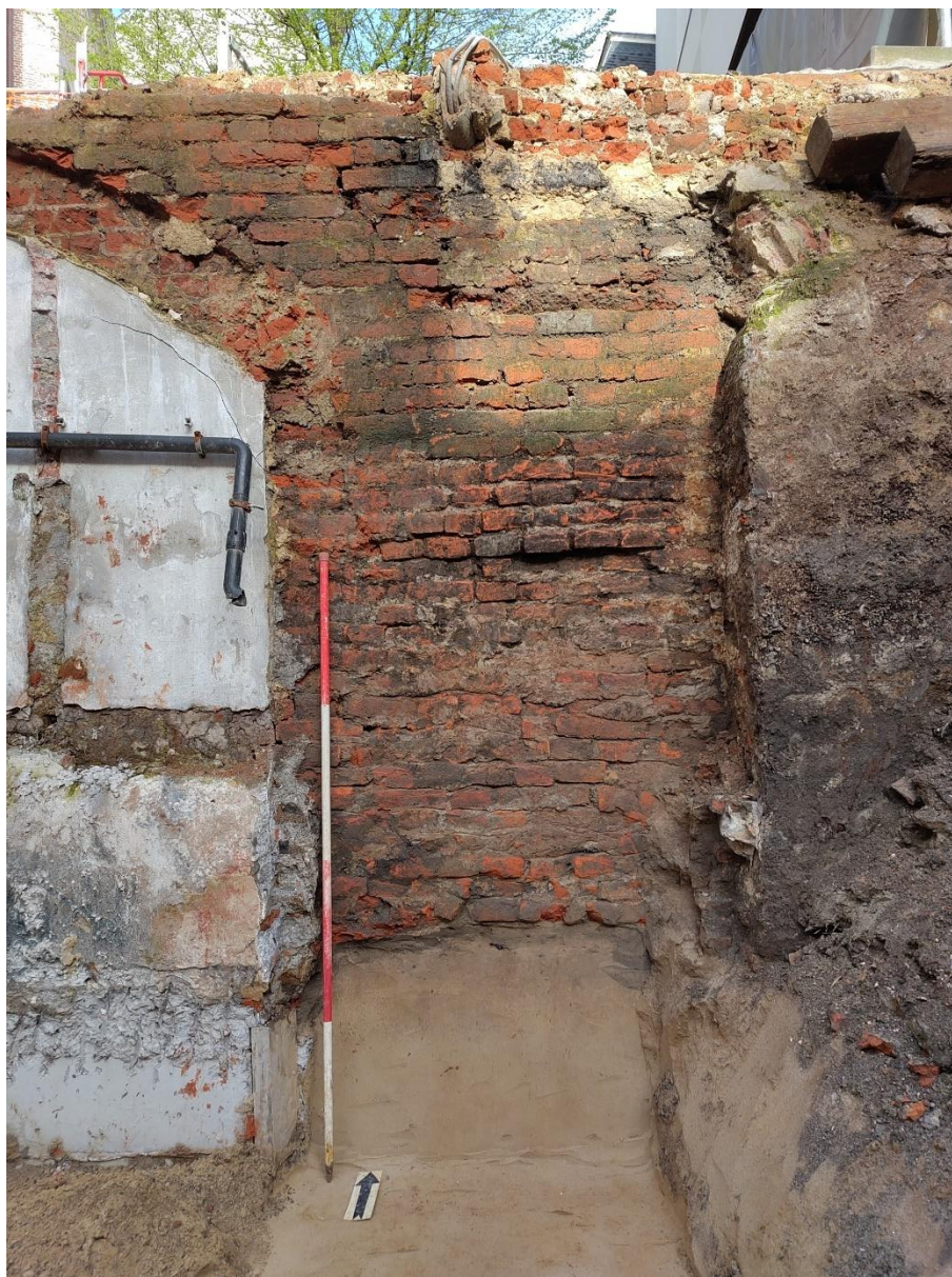
Figuur 18: foto van muur 1002.
