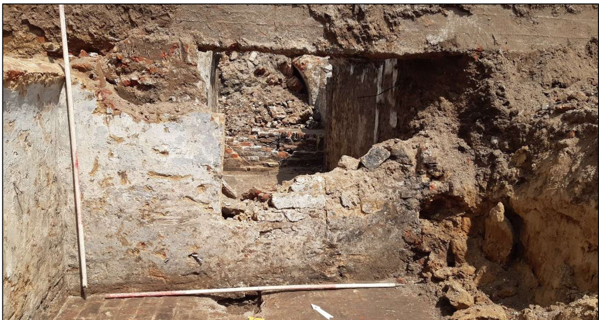
Figuur 38: Scheidingsmuur tussen kelder S3015 en S5016
