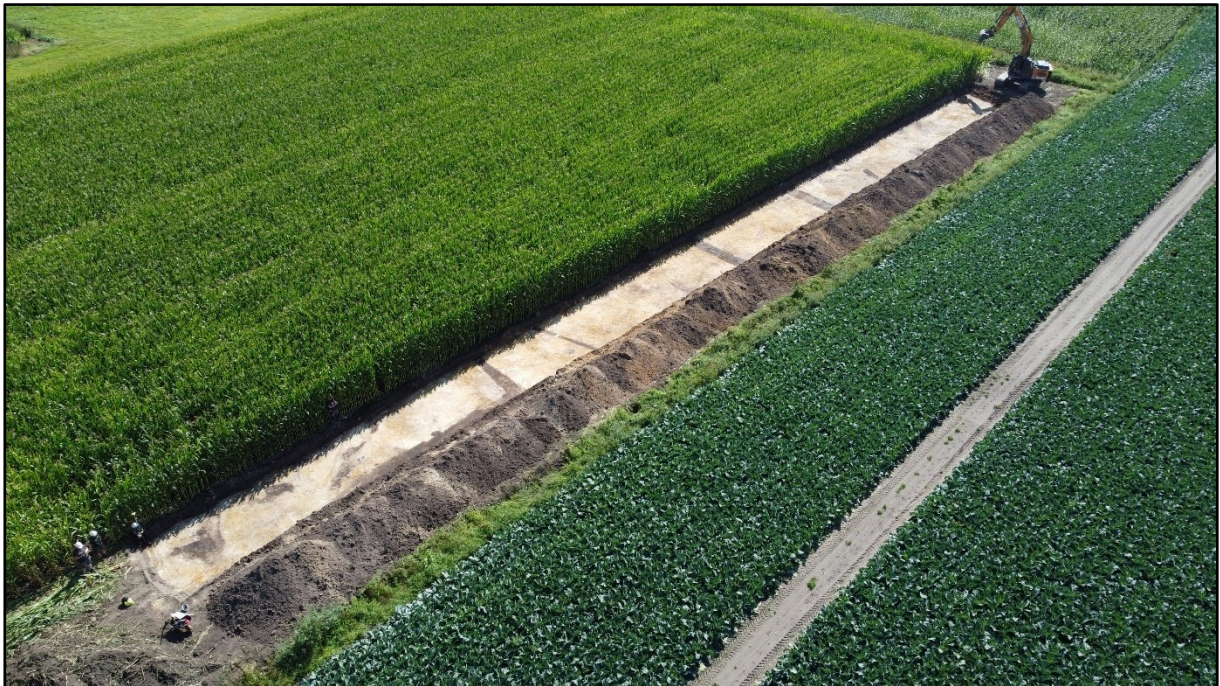
Figuur 16: Drone-opname tijdens de aanleg van het opgravingsvlak in werkput 2 (ABO nv 2024)
