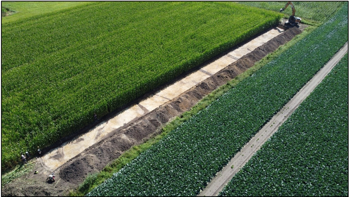
Figuur 4: Drone-opname tijdens de aanleg van het vlak in werkput 2 (ABO nv 2024)
