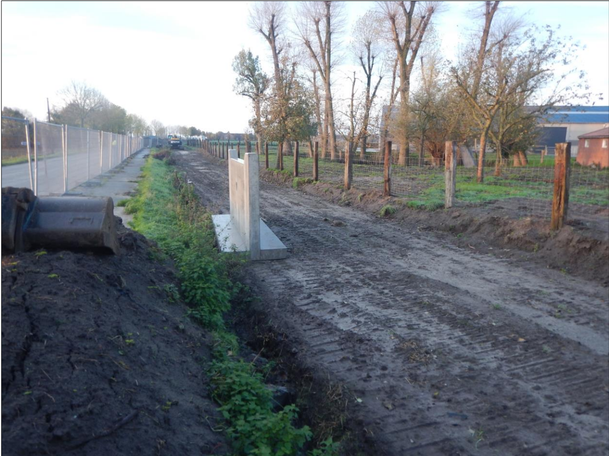
Figuur 8: Werkput na verwijderen teelaarde
