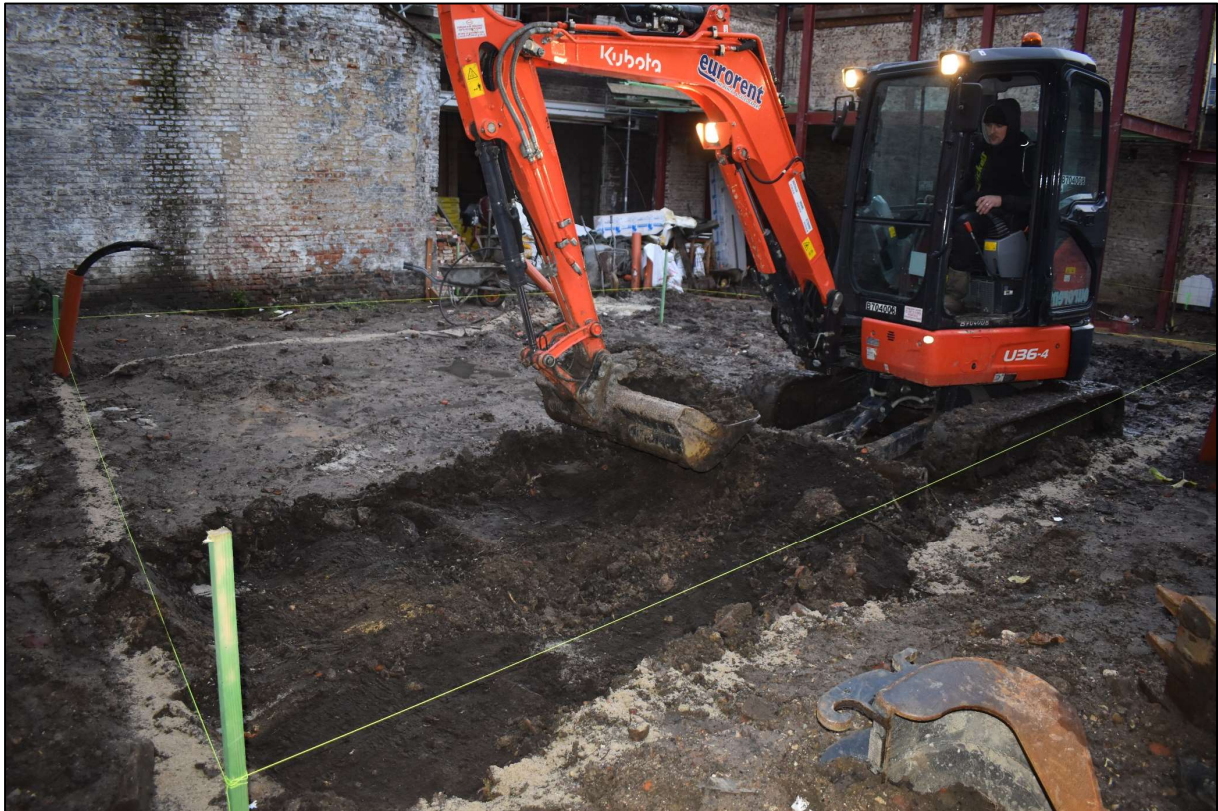
Afb. 5: Begin van de aanleg van vlak 1.
