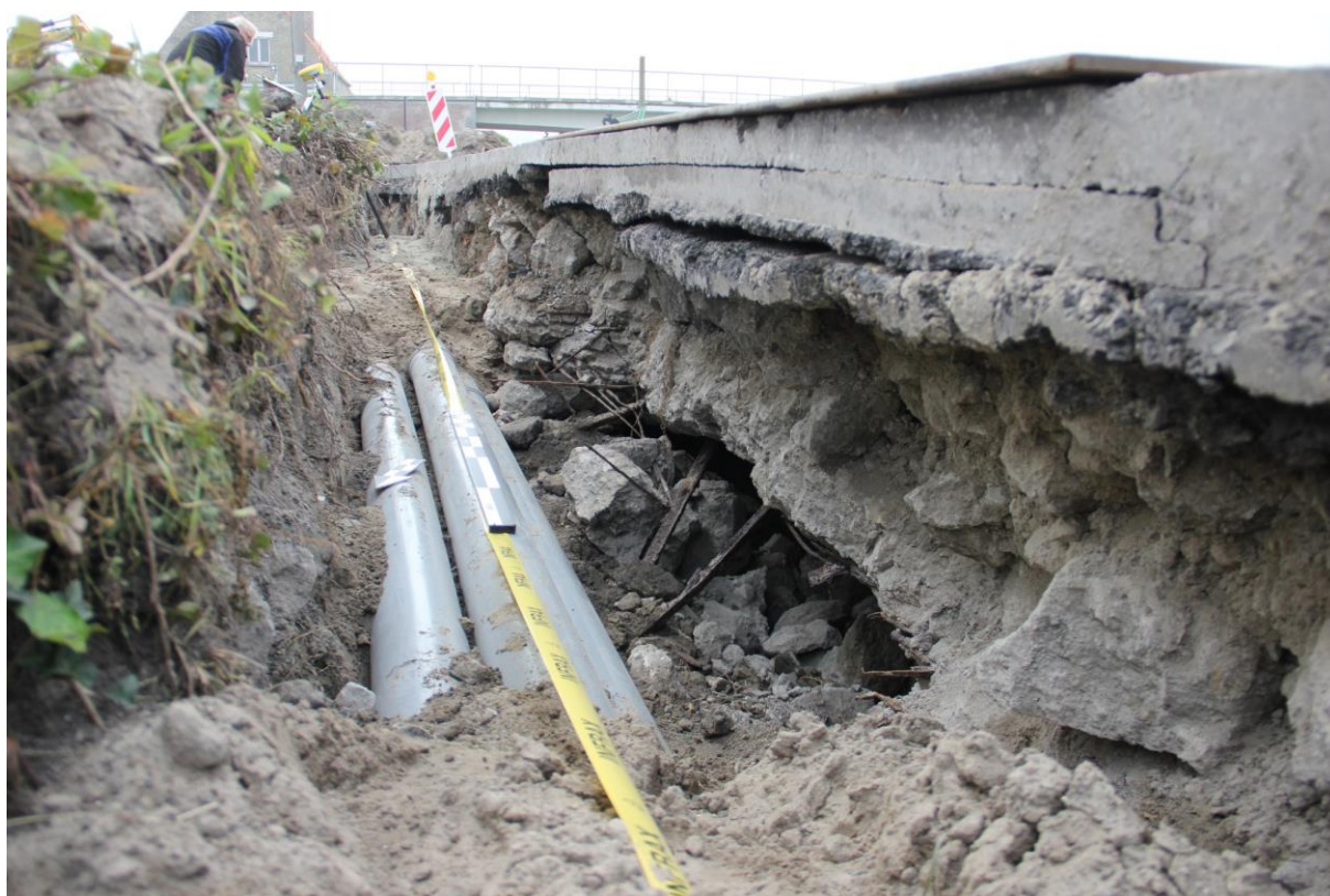
Fig. 6: Opname van kortbij met zicht op de doorsneden zijmuur van de bunker (rechts). Let op de wapening, die zowel uit betonijzer als uit staven bestaat.
