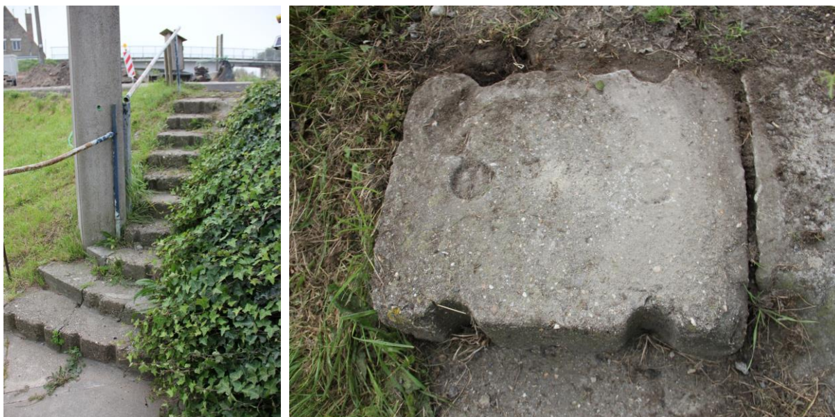
Fig. 19 en 20: Trap aan de zuidwesthoek van huis IJzerdijk nr. 1, net ten zuidoosten van de aangetroffen bunker. De trap is opgebouwd met bunkerblokken. In de blokken (50 x 40 x 20 cm) zijn uitsparingen en gaten voorzien om betonijzer aan te brengen.
