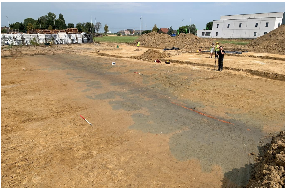
Figuur 10: Sfeerbeeld tijdens de werkzaamheden (© Monument Vandekerckhove).
