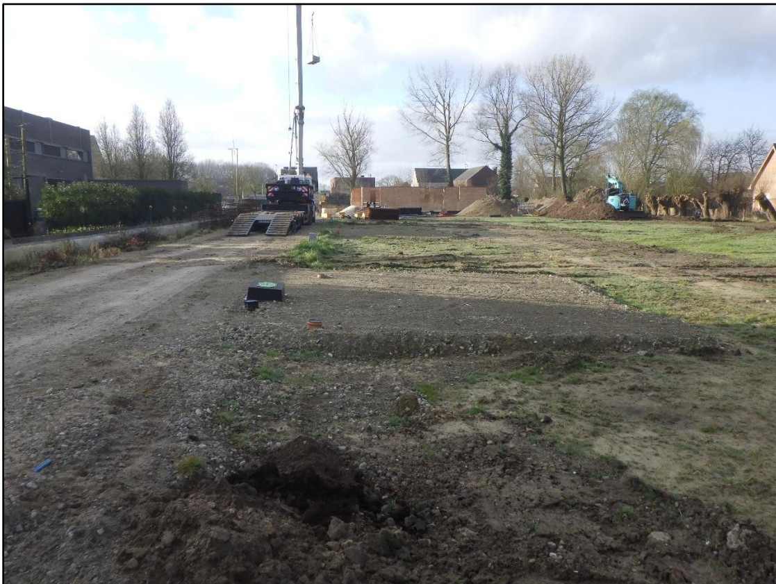
Figuur 12 Zicht op één van de reeds aangelegde opritten met nutsvoorzieningen.
